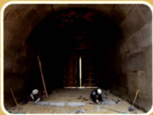
홍예 하부 박석 설치
