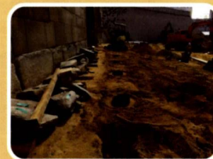
경관 조명 설치
