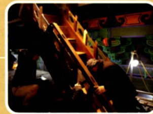
문루 조립-계단 보수
