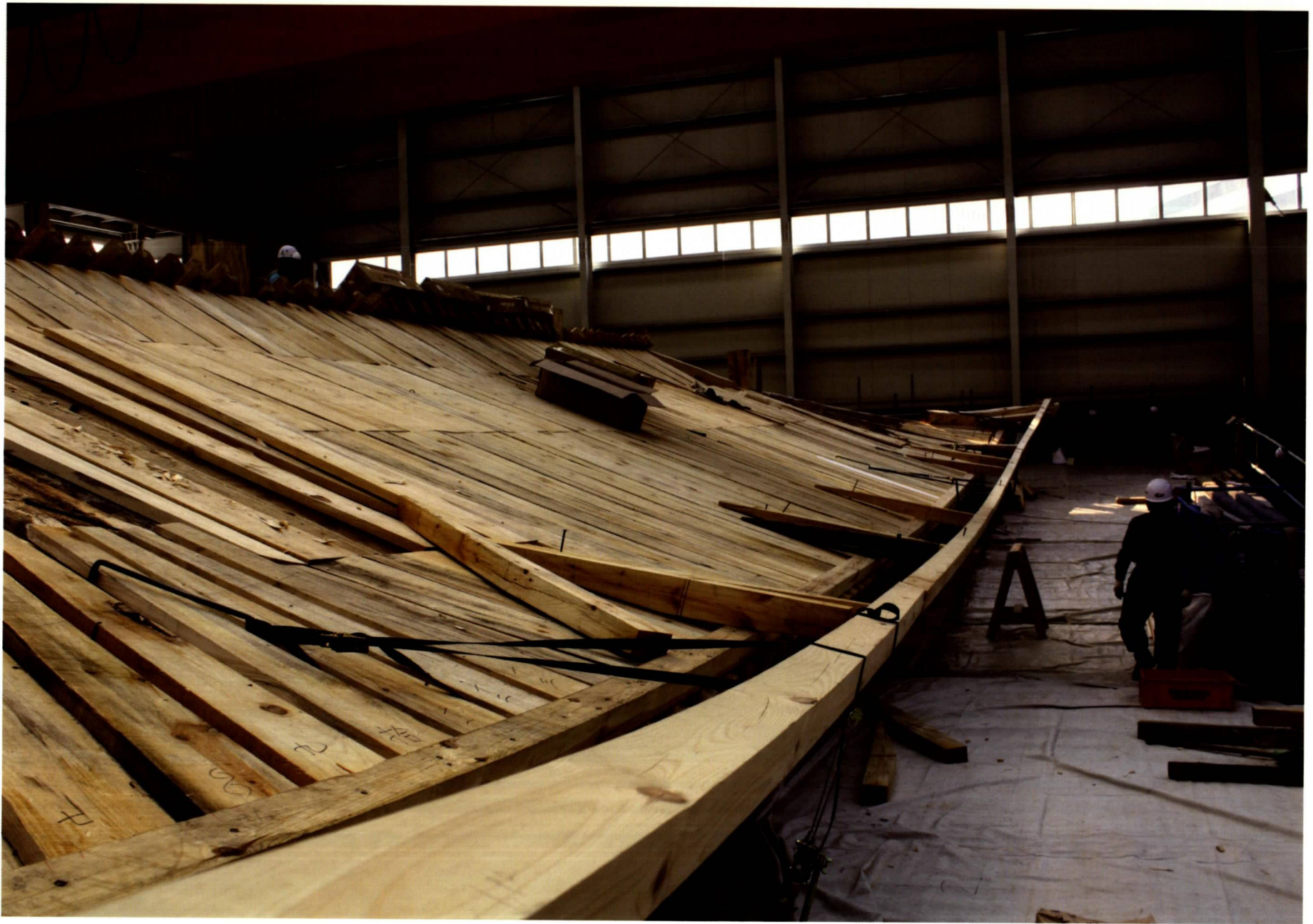
문루 상층 조립-부연 조립 (2012_05)
