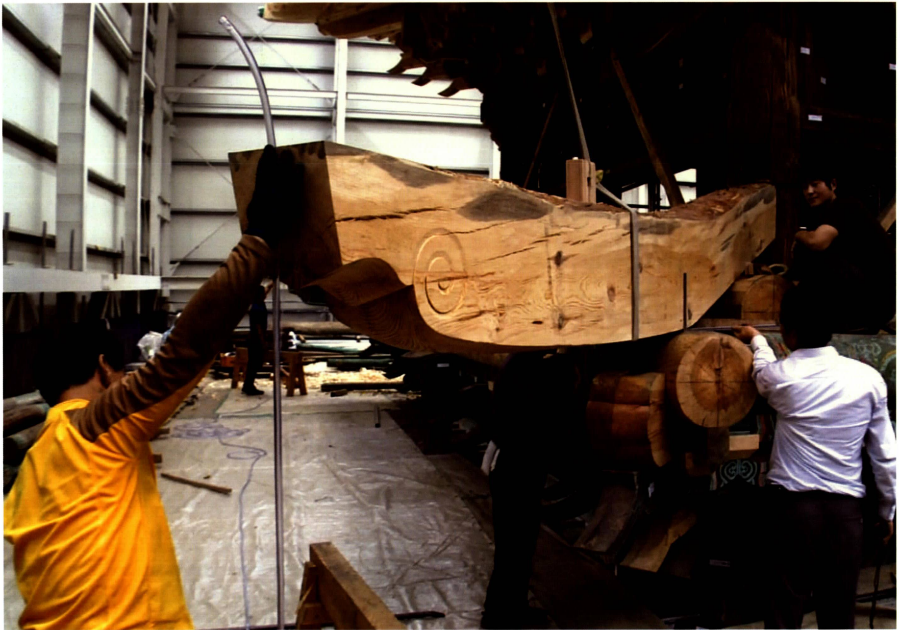
문루 하층 조립-추녀 조립 (2012_07)
