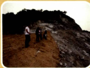
박석 채취장 복구 공사
