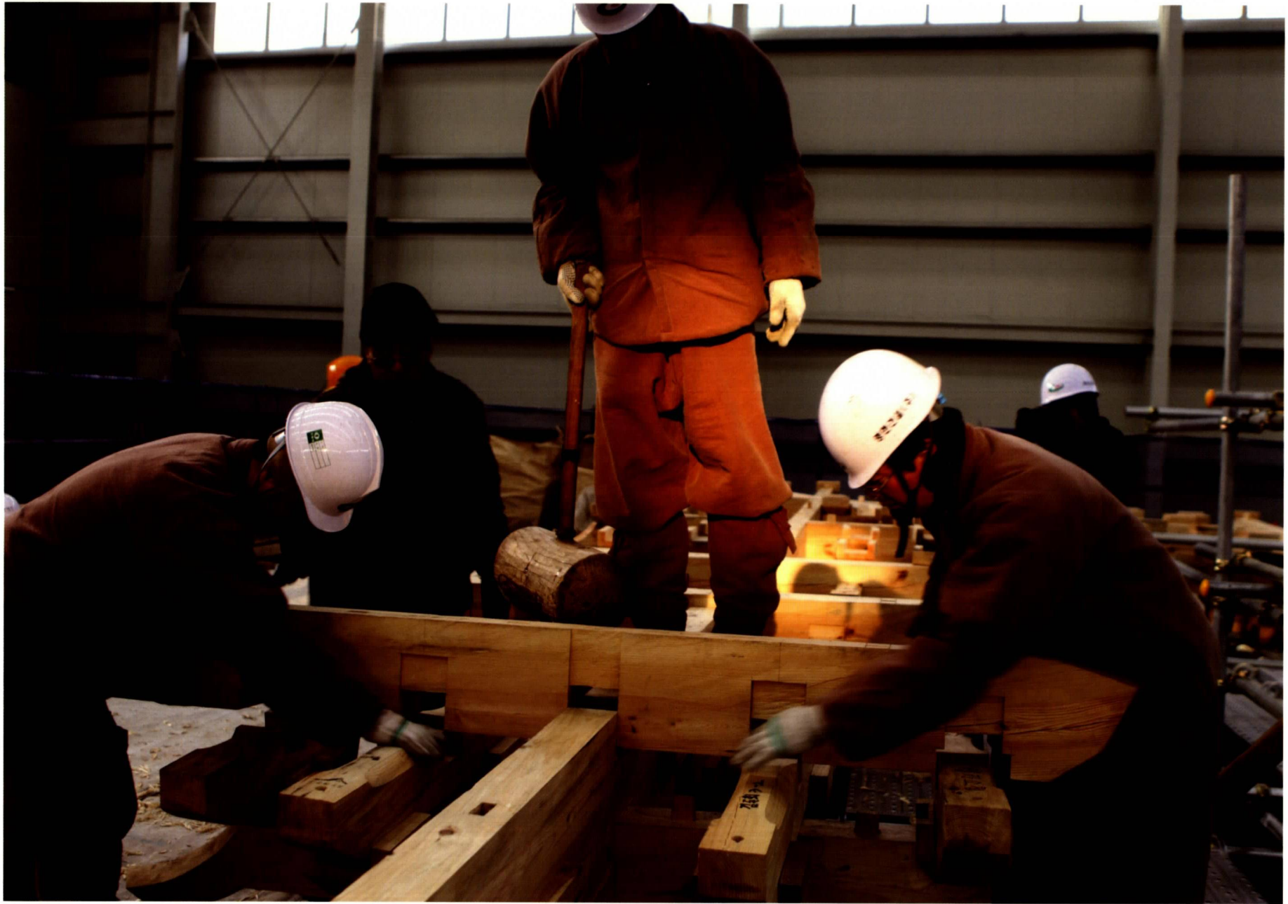
문루 상층 조립-공포 조립 (2012_02)
