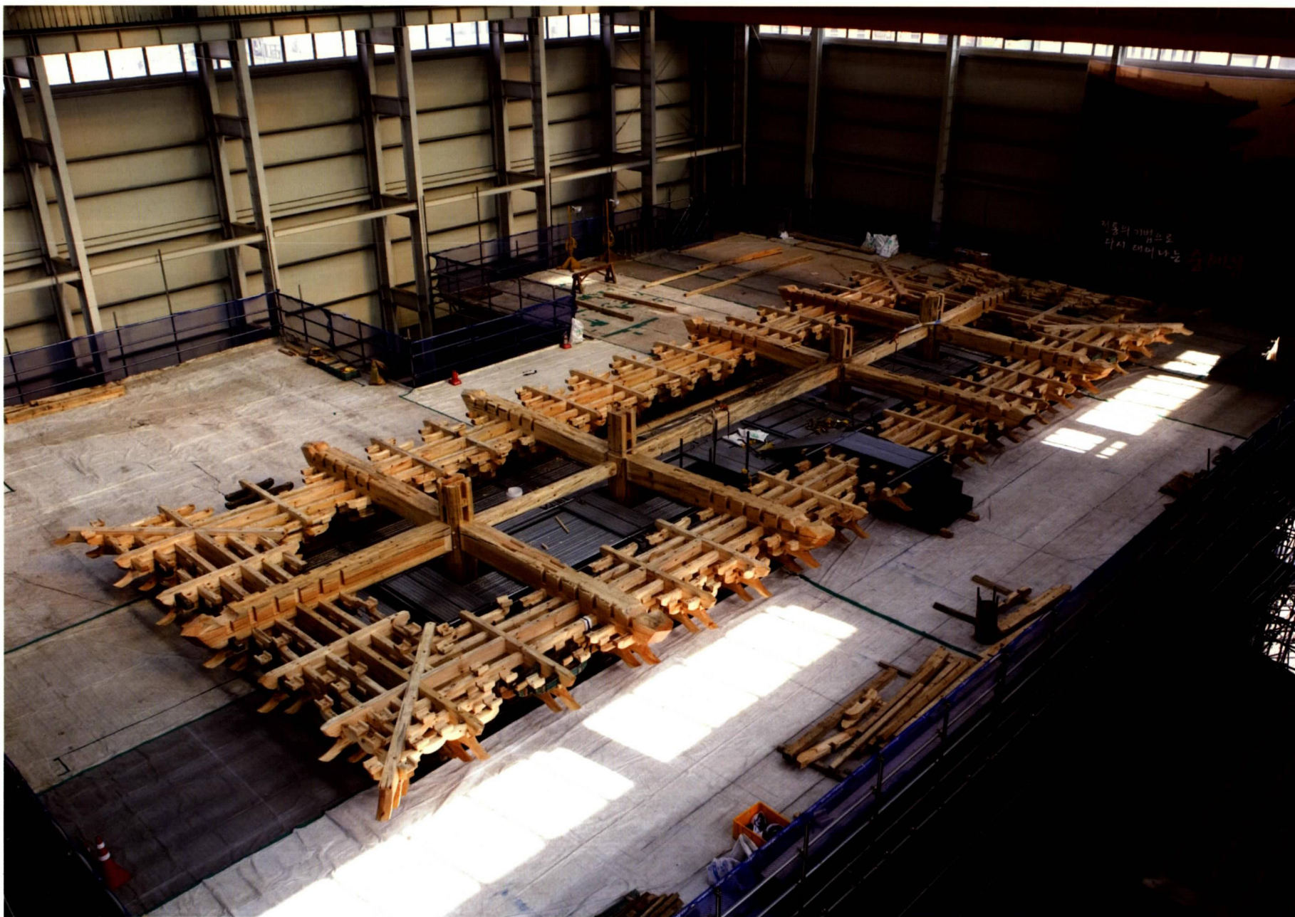
문루 상층 조립-보 조립 완료 후 전경 (2012_02)
