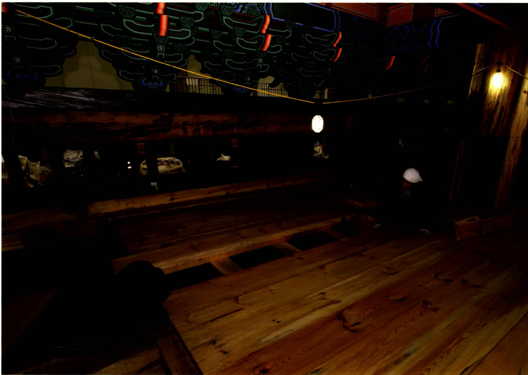
문루 상층 조립-마루 설치 (2012_11)
