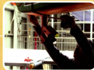
불꽃 감지기 설치
