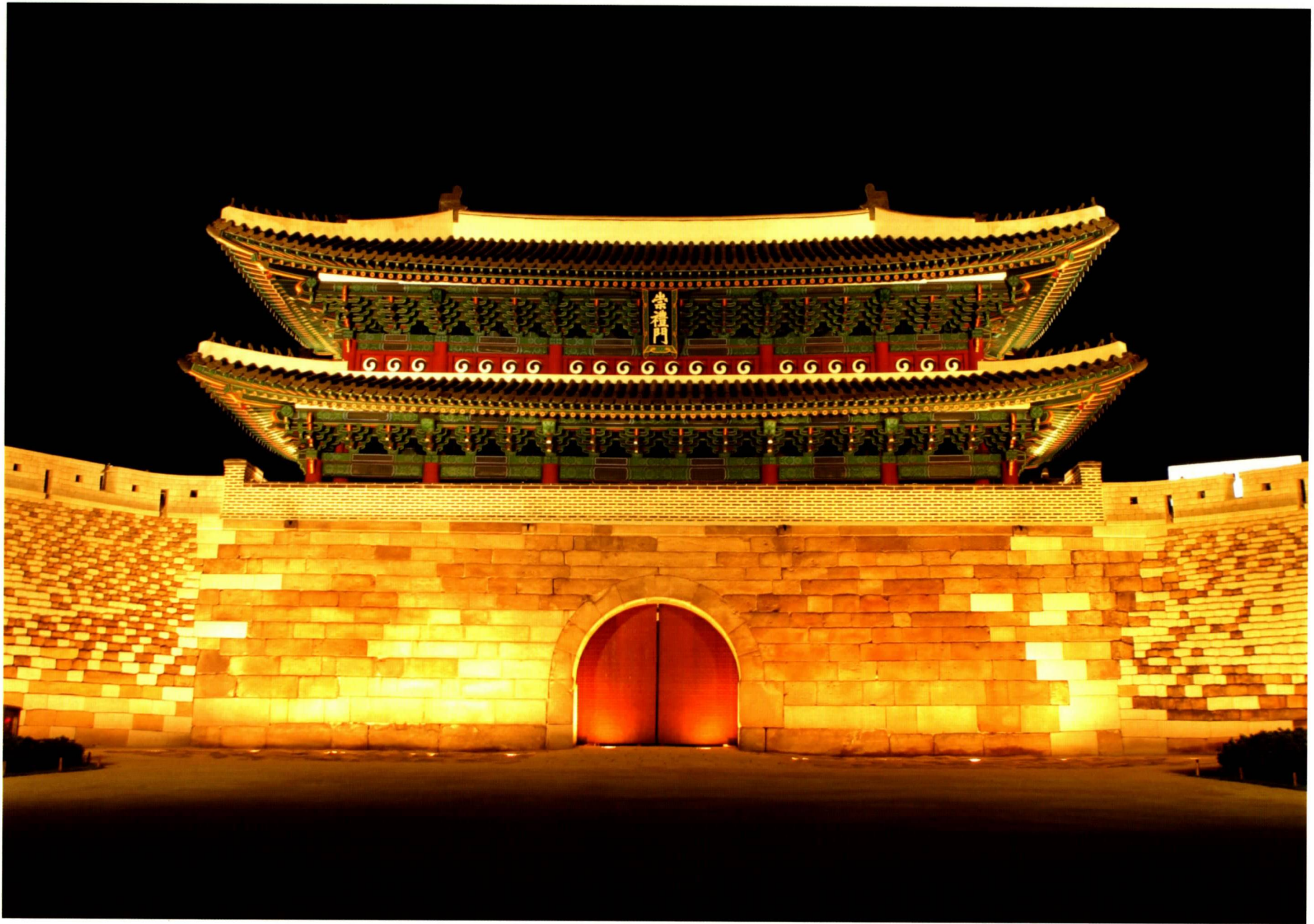
복구 후 숭례문 야경-정면 (2013_05)
