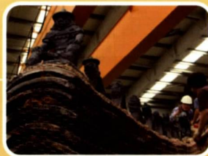
상층 추녀마루 잡상 설치
