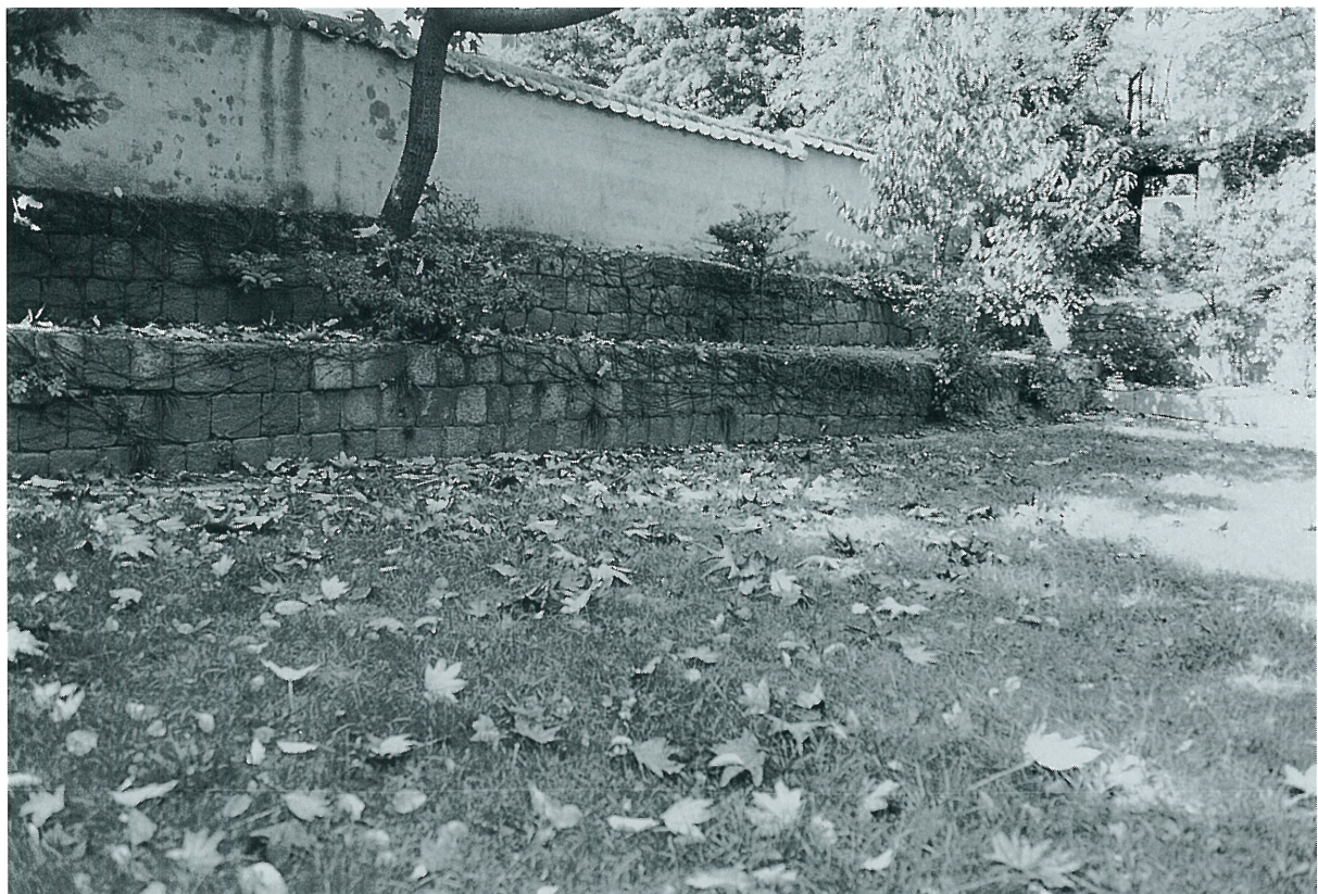
[사진 6] 미국 대사관 관저 주변 석축 전경 ① 북쪽 장대석 석축, ② 서쪽 사고석 석축
