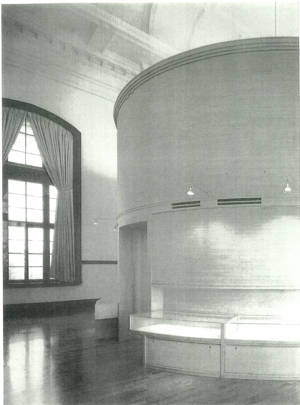
3층 「本のミュージアム」。部屋の中央に置かれたふたつの円筒形の展示装置には、空調機が組み込まれている。床は配管のためにほぼ幅木分嵩上げされているが、壁際
