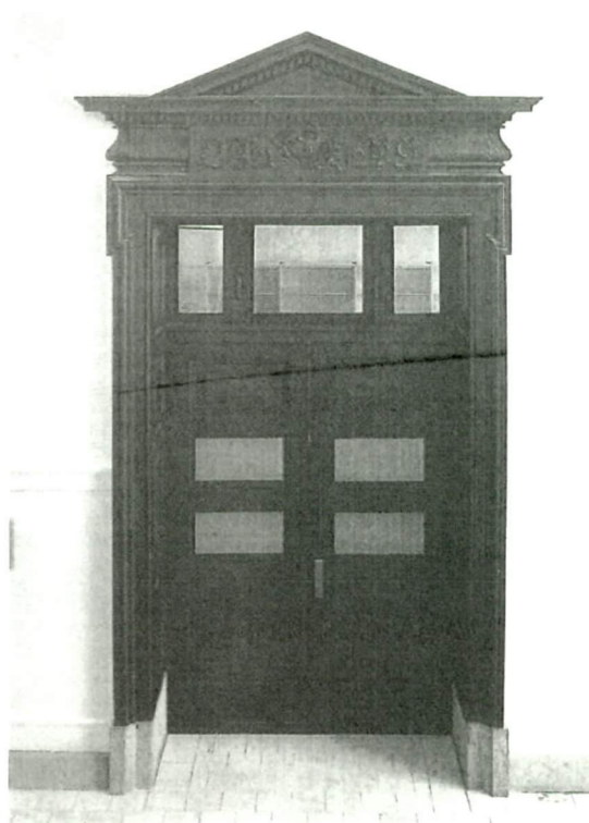
2階。大階段に面したベディメントをもつ扉。
