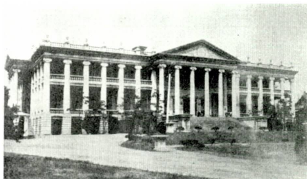
사진2-2. 공사가 완공된 직후의 석조전, 『大成建設社史』
