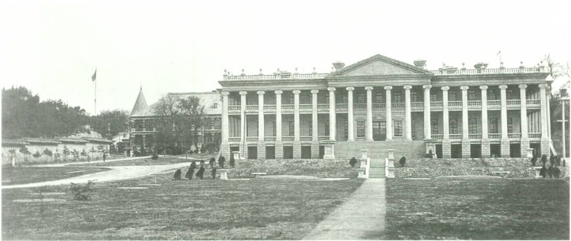
사진 1-5. 석조전 전경(돈덕전과의 위치관계를 잘 보여준다.), 1910년대, 출처: 일본 궁내청 소장 창덕궁 사진첩
