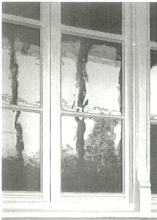
補修、再使用された2階の木製建具。
