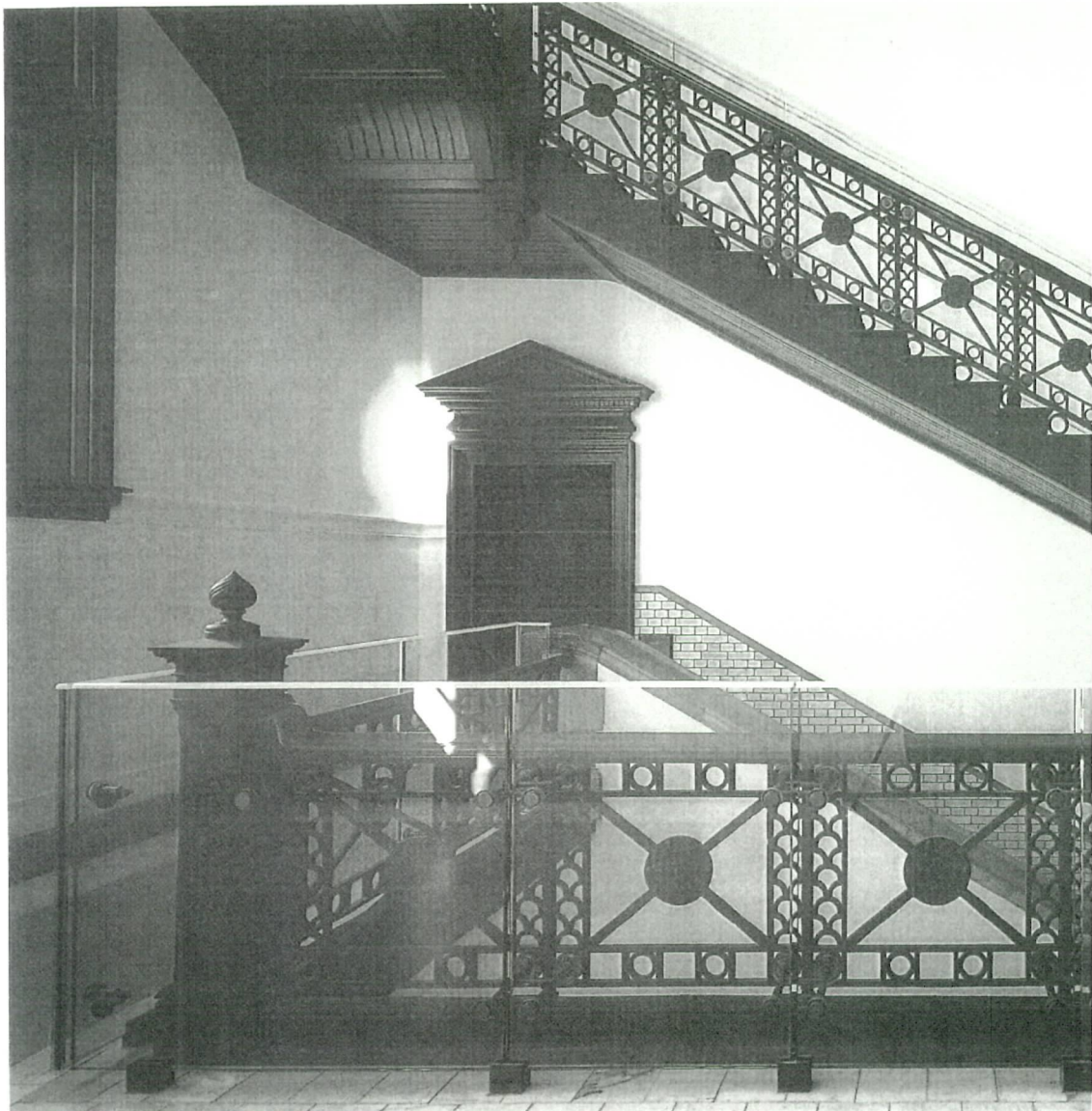
大階段 2 階レベルの廊下より南方向を見る。現在の安全基準に適さない既存の鑄鉄製の手摺の内側にガラスの手摺を新設している。
