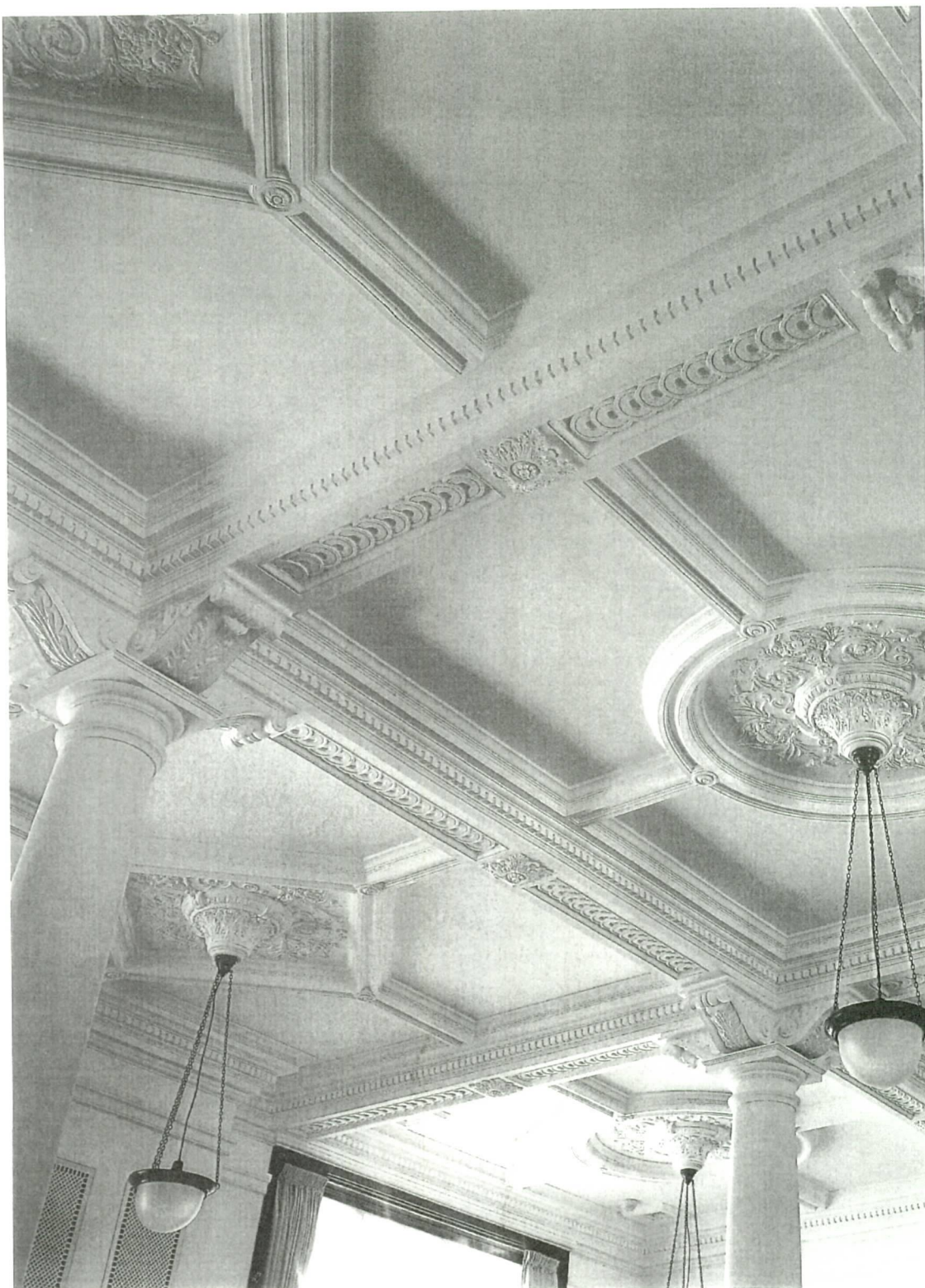
2階、旧特別閲覧室の「第二資料室」天井を見る。4本の柱は鉄骨の構造柱に竹木舞の下地でふくらみを出し、漆喰で仕上げられている。
