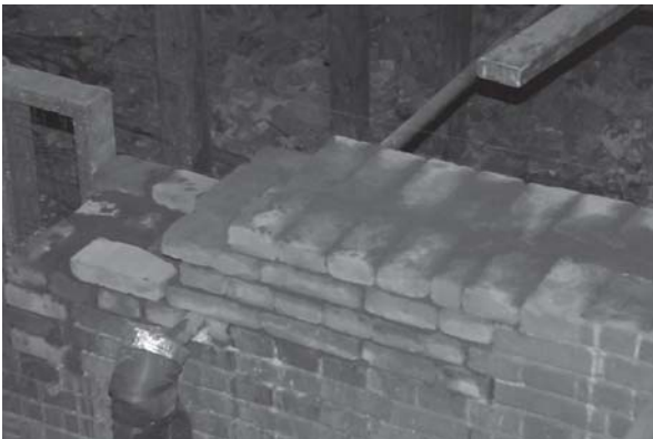
[사진 4-26] 지하 1층 조적벽 쌓기
