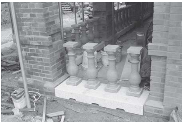
[사진 4-114] 난간 동자석 설치
