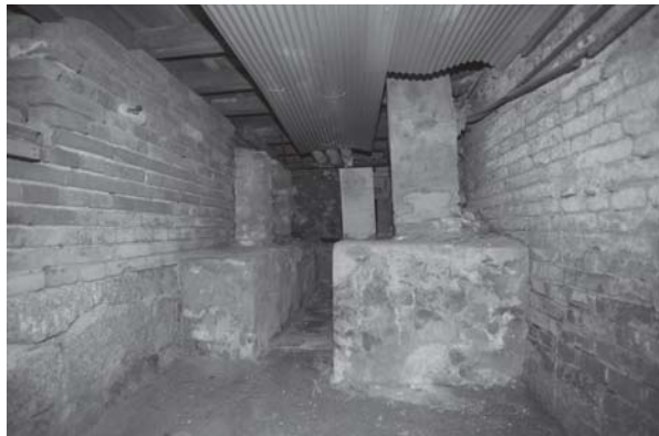
[사진 3-22] 지하 1층 ⑩ 방향 모습
