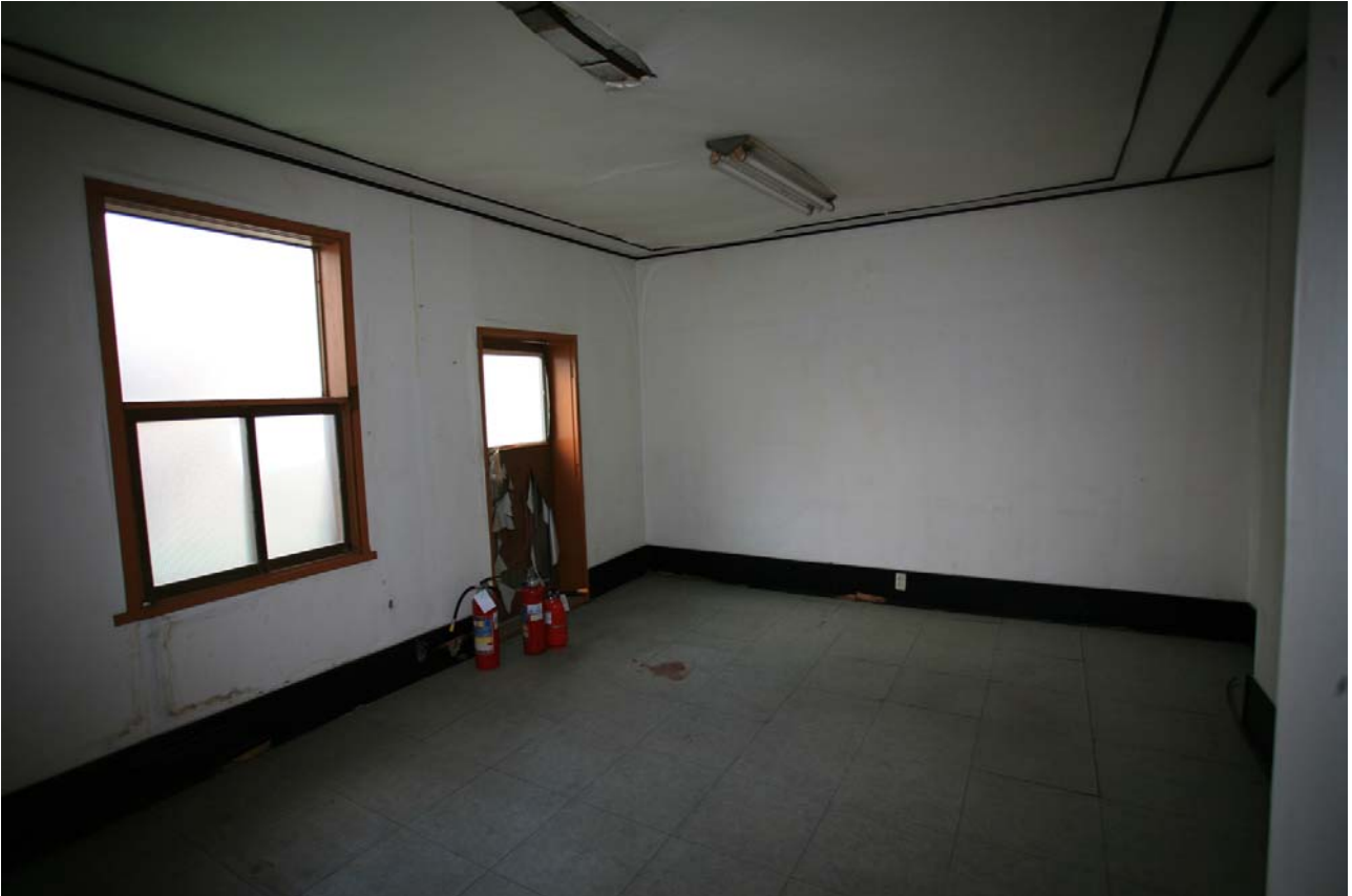
중명전 2층 북쪽 좌측방 내부(보수 전)
