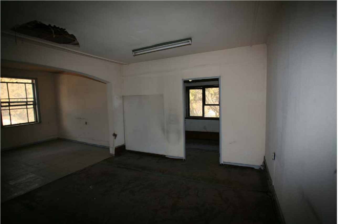
중명전 2층 북쪽 우측방 내부(보수 전)
