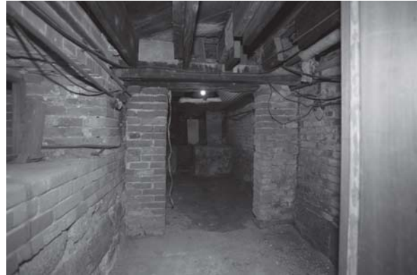
[사진 3-20] 지하 1층 ⑧ 방향 모습
