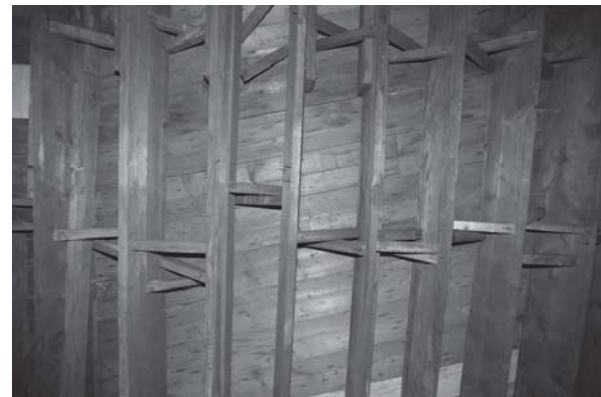
[사진 3-116] 2층 마루 장선과 가새
