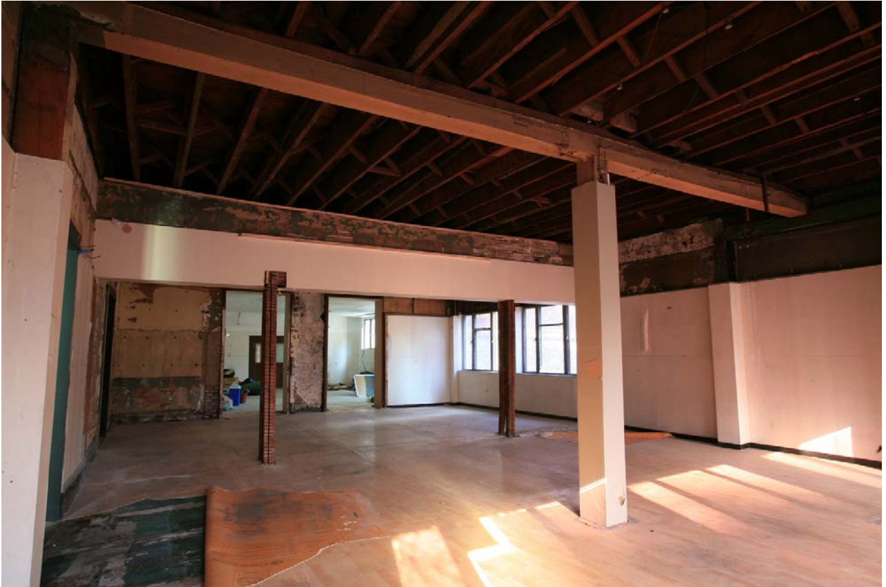
중명전 1층 동쪽방 내부(보수 전)
