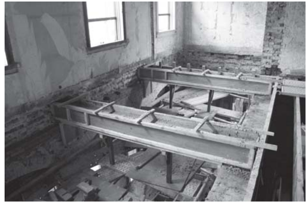
[사진 4-51] 콘크리트 보강 보 거푸집 설치
