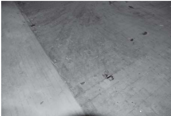
[사진 3-119] 1층 마루 바닥 마감(실 5 부분)
