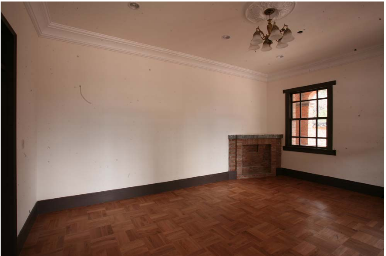
중명전 1층 동쪽방 내부(보수 후)
