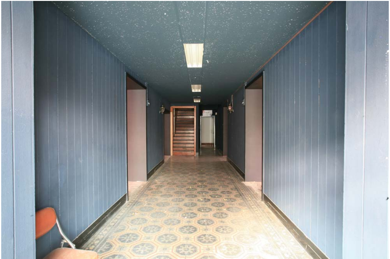
중명전 1층 복도 바닥(보수 전)
