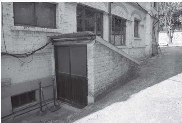
[사진 3-9] 동쪽에 생긴 지하 출입구
