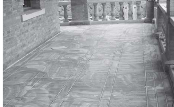
[사진 4-84] 완성된 회랑 바닥
