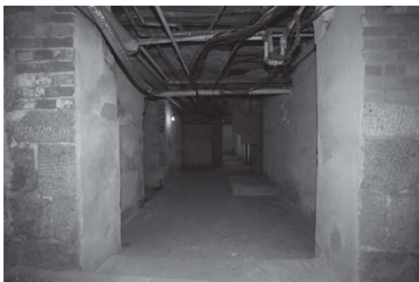
[사진 3-49] 지하 1층 ㉟ 방향 모습
