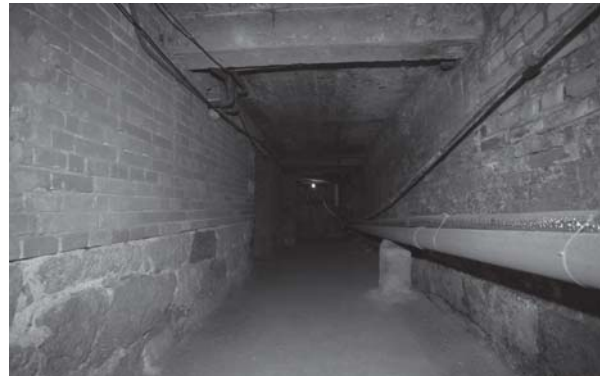
[사진 3-40] 지하 1층 ㉘ 방향 모습
