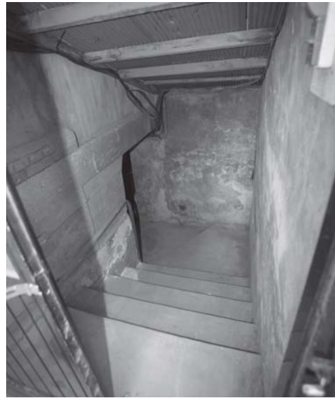
[사진 3-13] 지하 1층 ① 방향 모습
