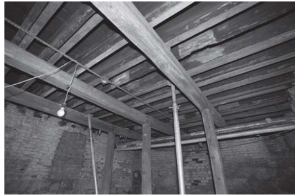
[사진 3-44] 지하 1층 ㉔ 방향 모습
