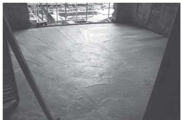
[사진 4-65] 콘크리트 타설
