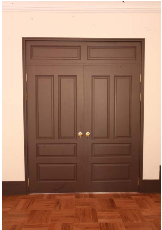
중명전 문(보수 후)
