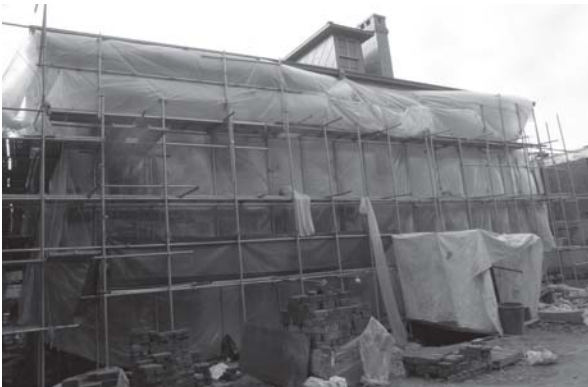
[사진 4-76] 샌딩작업을 위한 분진 가림막 및 집진기 설치
