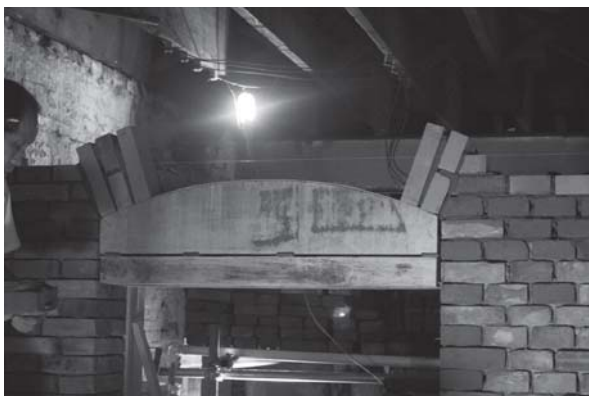
[사진 4-32] 1층 창 상부 아치틀과 벽돌쌓기(쌓기 중)
