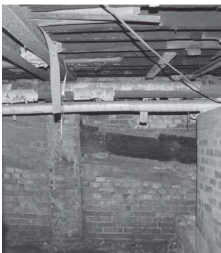
[사진 3-47] 지하 1층 ㉗ 방향 모습
