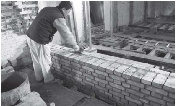
[사진 4-29] 1층 조적벽 쌓기
