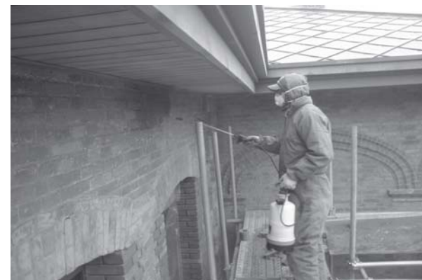
[사진 4-73] 페인트 제거 후 발수경화제 도포
