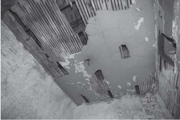
[사진 3-125] 1층 '실 3'의 천장 마감(줄대 바탕에 석회물탈을 바르고 페인트로 칠해져 있다.)
