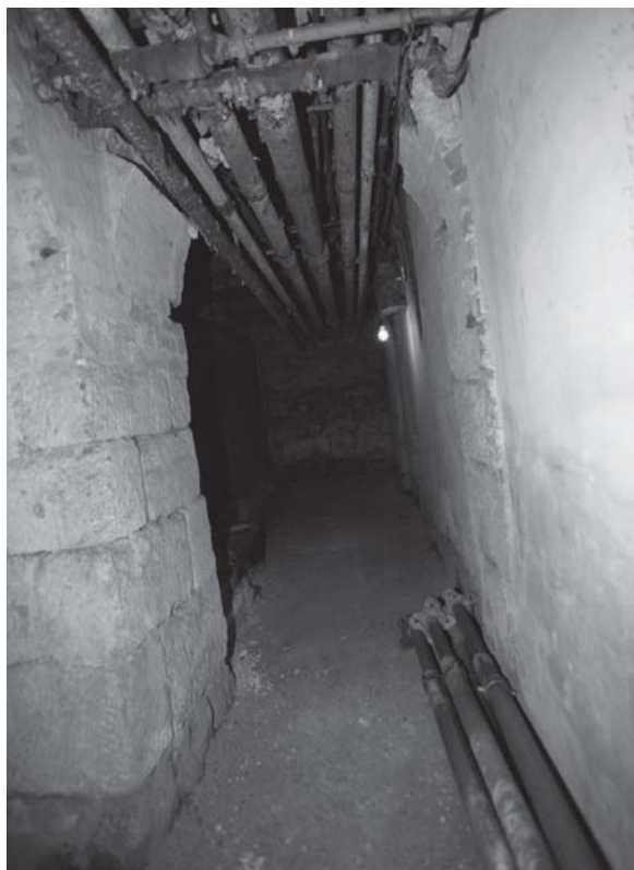
[사진 3-53] 지하 1층 ㊻ 방향 모습
