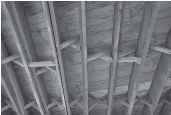
[사진 3-115] 2층 마루 장선과 가새
