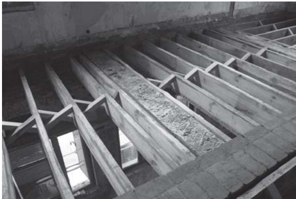
[사진 4-58] 2층 마루 장선 설치
