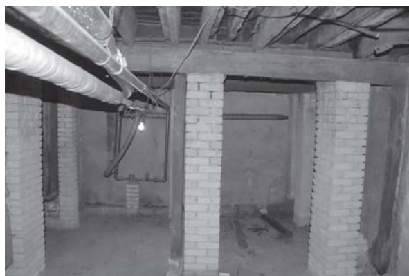
[사진 3-50] 지하 1층 ㊸ 방향 모습
