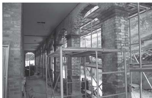
[사진 4-39] 1층 외벽 해체공사
