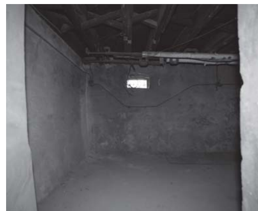
[사진 3-18] 지하 1층 ⑥ 방향 모습
