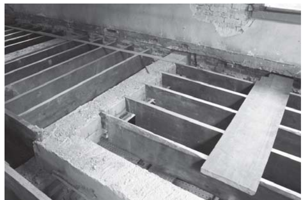
[사진 4-53] 콘크리트 보강 보 완성
