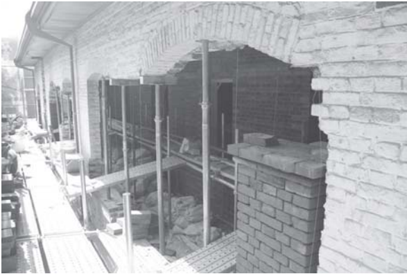
[사진 4-44] 2층 외벽 일부 헐어내기
