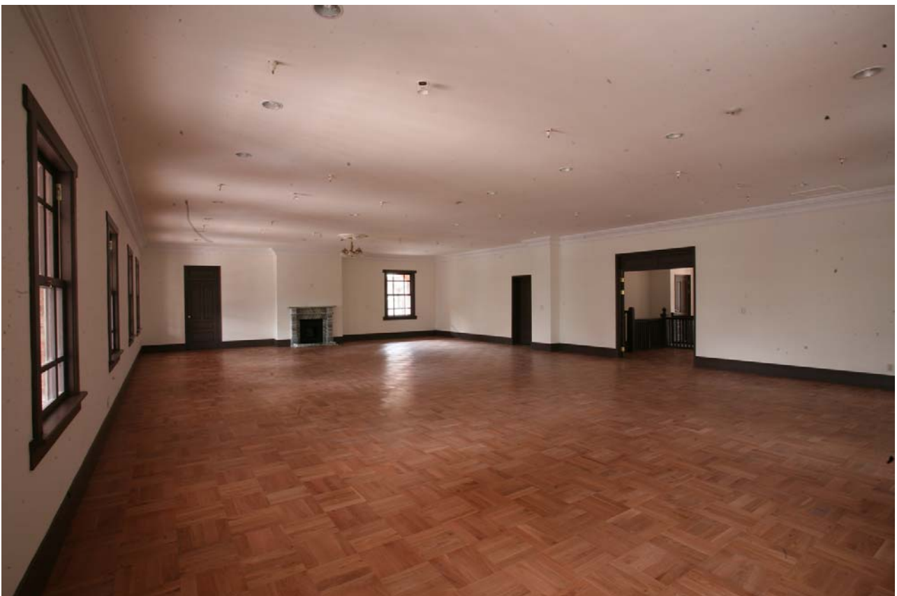
중명전 2층 남쪽방 내부(보수 후)
