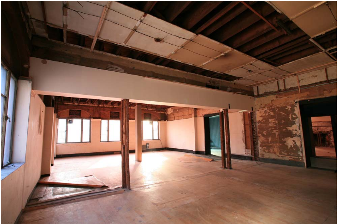
중명전 1층 동쪽방 내부(보수 전)
