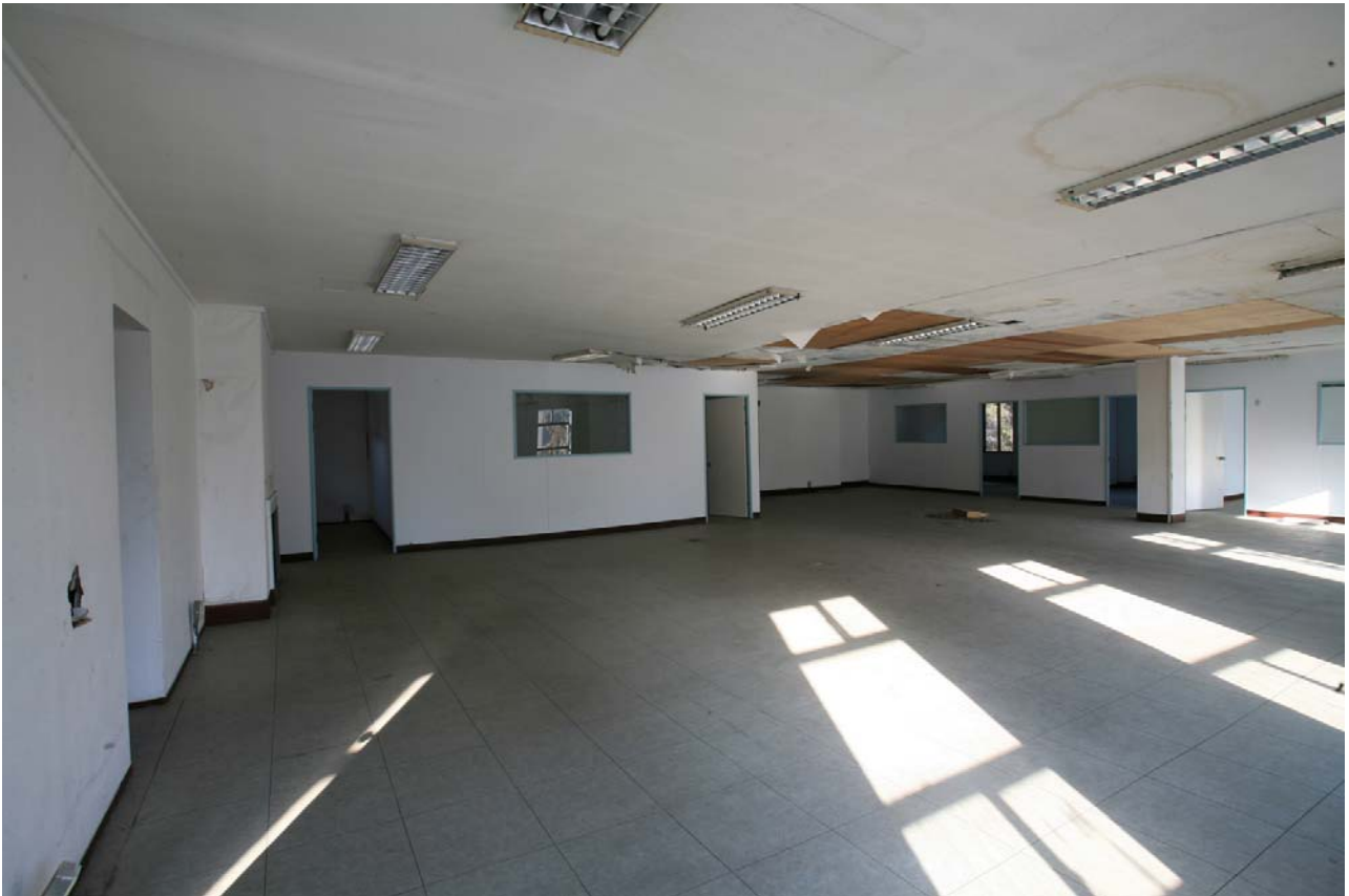
중명전 2층 남쪽방 내부(보수 전)
