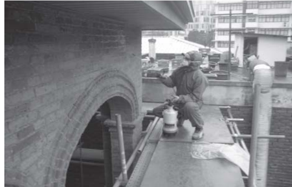
[사진 4-75] 페인트 제거 후 발수경화제 도포
