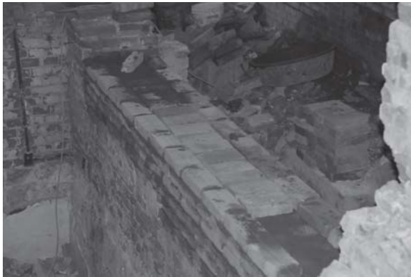
[사진 3-4] 중명전의 2매쌓기 벽체구성의 시공현황사진(길이 면이 보이는 커)
