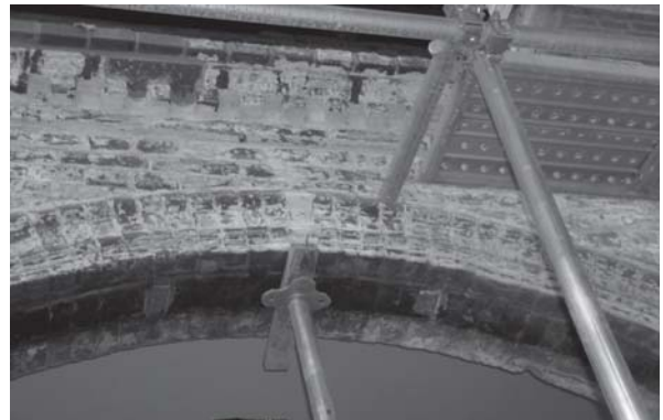
[사진 4-69] 1차 페인트 도막제거 상태
