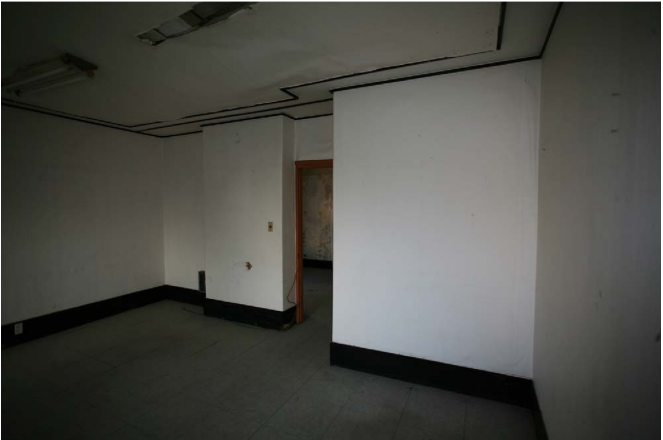
중명전 2층 북쪽 좌측방 내부(보수 전)
