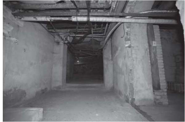
[사진 3-36] 지하 1층 ㉔ 방향 모습
