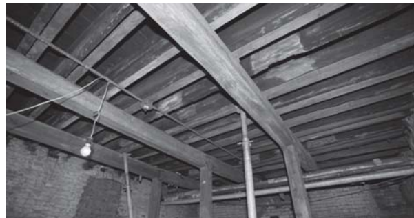
[사진 3-112] 1층 마루 장선의 구성(색깔 차이가 난다)
