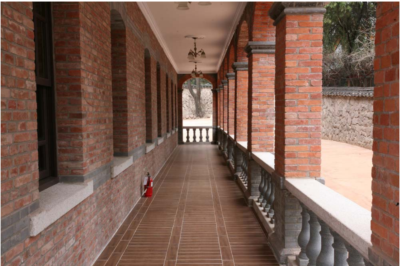
중명전 1층 동측 회랑(보수 후)
