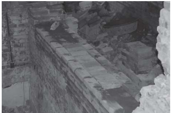
[사진 4-27] 지하 1층 조적벽 쌓기
