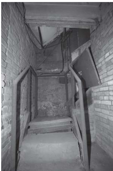
[사진 3-33] 지하 1층 ⑫ 방향 모습
