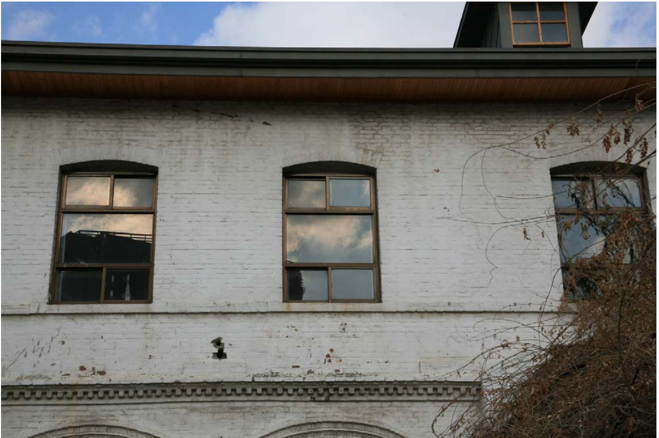
중명전 정면 2층 입면(보수 전)
