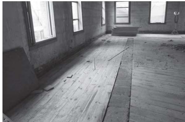
[사진 4-63] 1층 마루 설치공사
