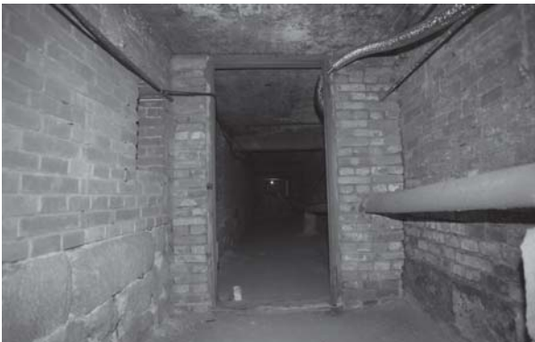
[사진 3-39] 지하 1층 ㉗ 방향 모습
