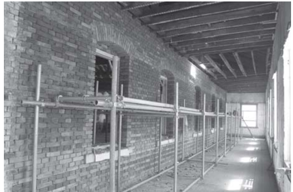
[사진 4-43] 2층 회랑 내벽 조적공사 완료
