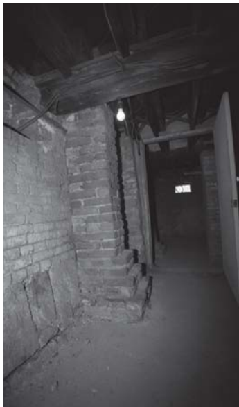
[사진 3-16] 지하 1층 ④ 방향 모습
