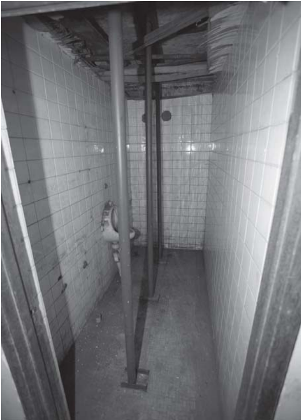
[사진 3-55] 지하 1층 ㉔ 방향 모습
