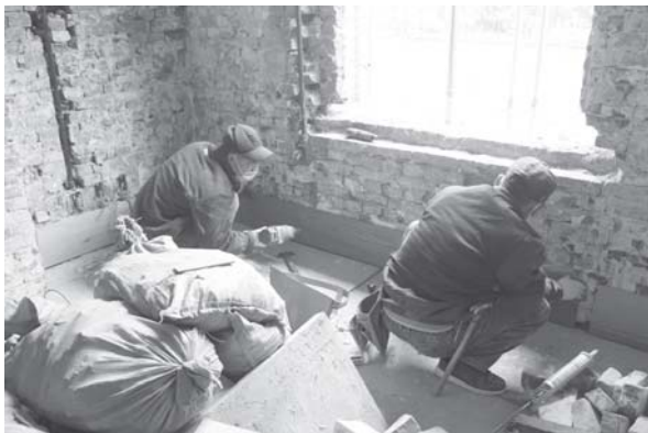
[사진 4-95] 걸레받이 바탕 설치
