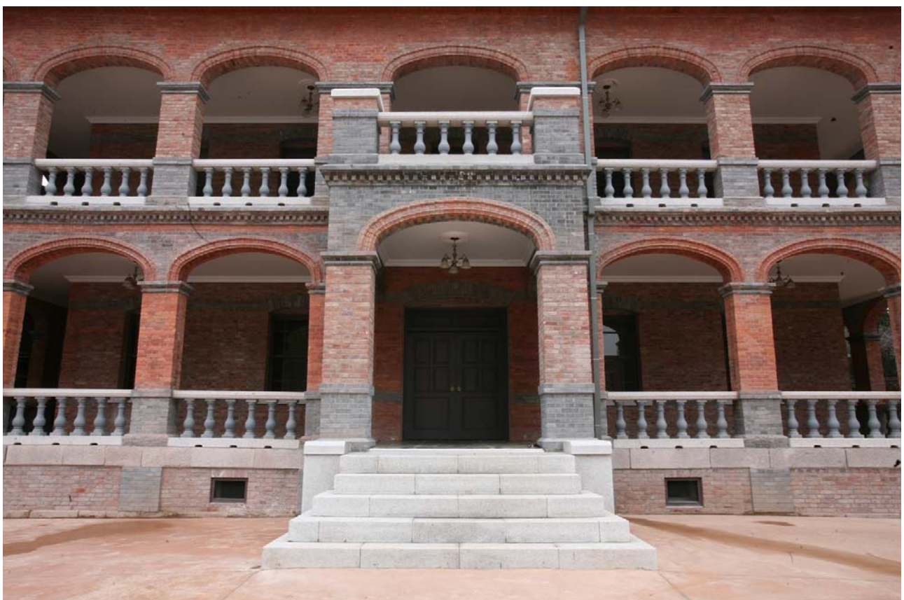
중명전 정면 현관(보수 후)
