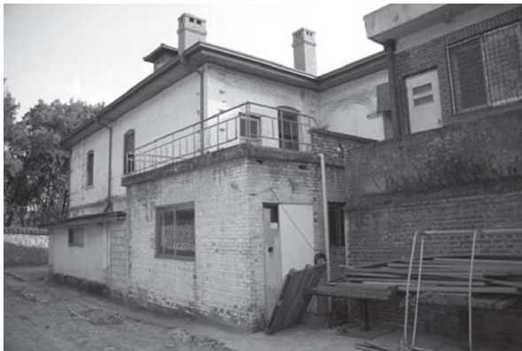
[사진 3-190] 배면 증축된 부분 철거 전 상태
