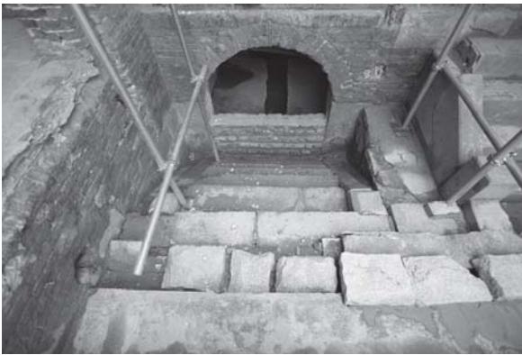
[사진 4-8] 지하 1층 출입구 원형모습
