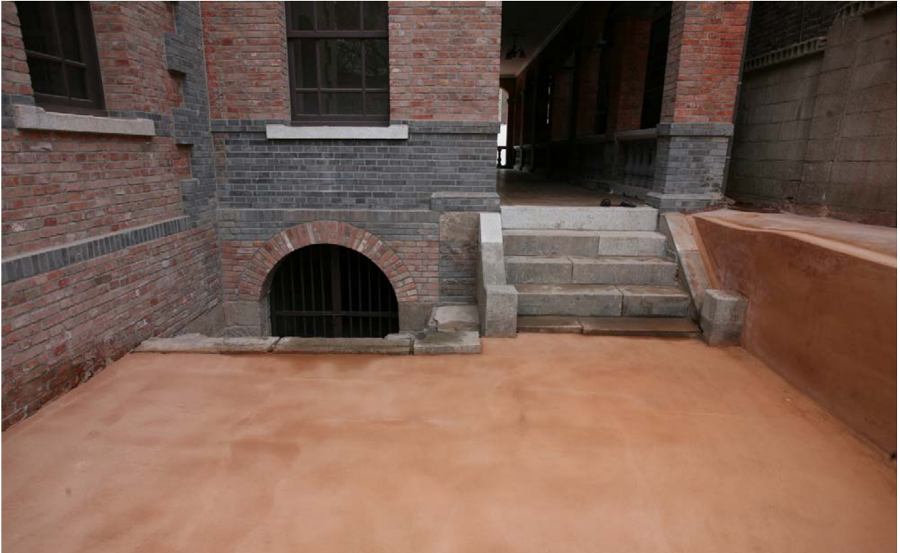
중명전 배면 지하출입구(보수 후)
