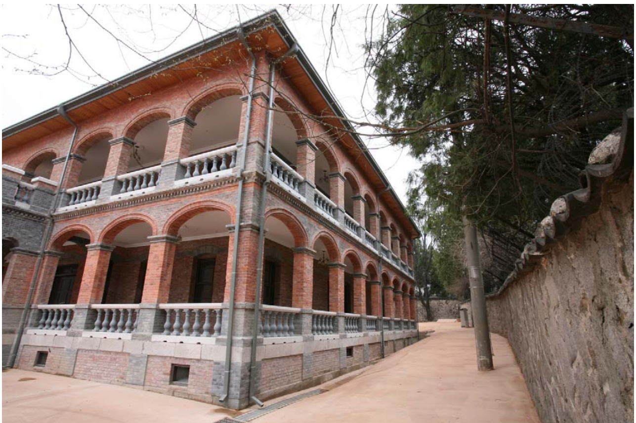
중명전 우측면(보수 후)
