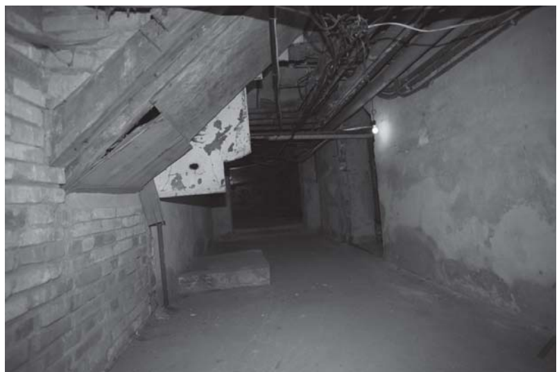
[사진 3-34] 지하 1층 ⑫ 방향 모습
