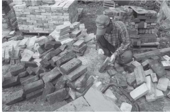
[사진 4-35] 기존 벽돌 재사용재 가공
