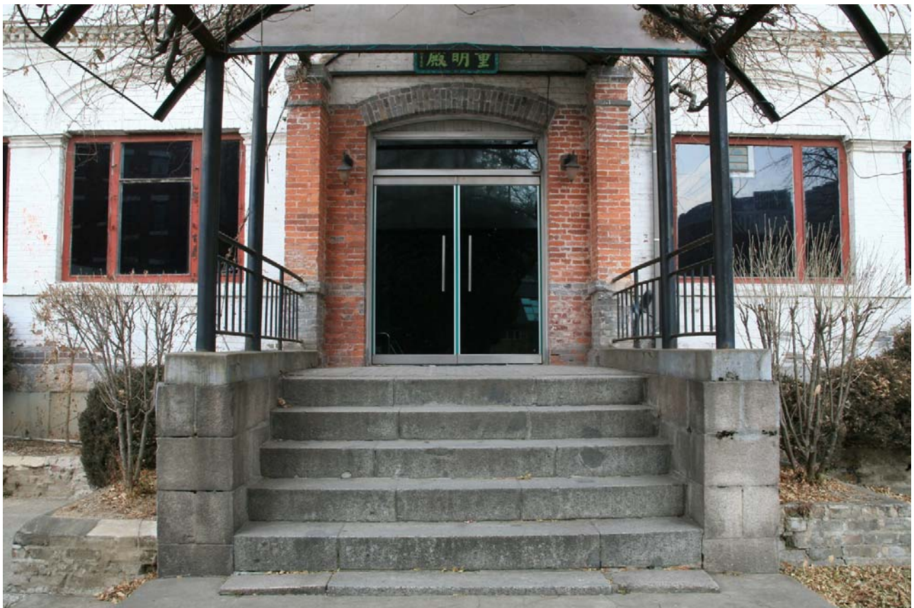
중명전 정면 현관(보수 전)
