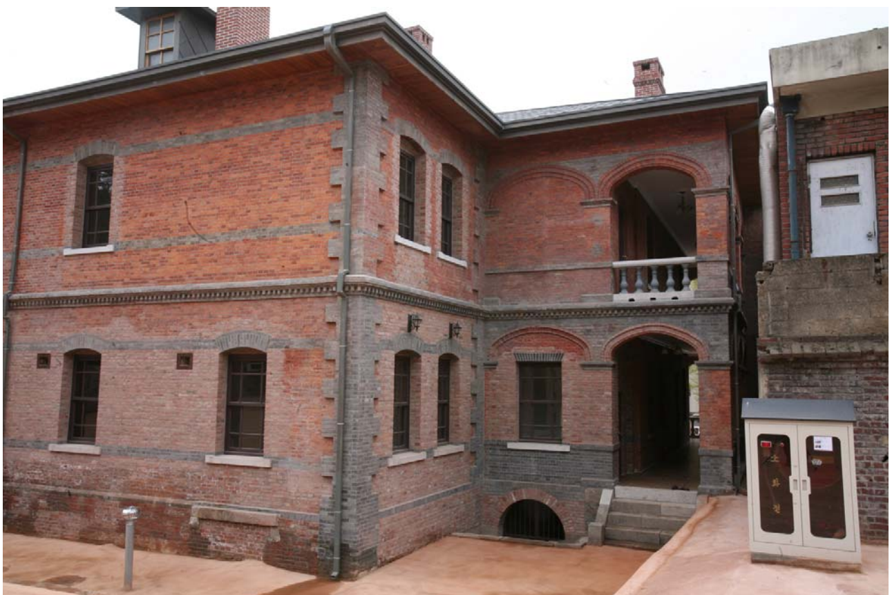
중명전 배면(보수 후)
