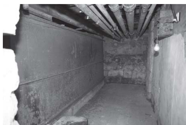
[사진 3-52] 지하 1층 ㊺ 방향 모습
