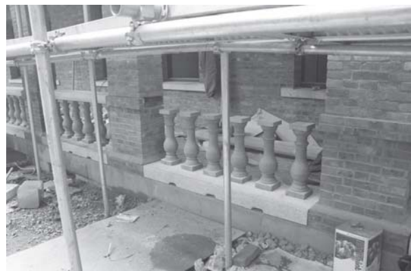
[사진 4-115] 난간 동자석 설치
