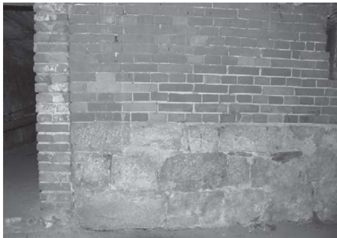
[도면 3-1] 중명전 화강석 줄기초 평면과 사진(실선부분이 화강석 줄기초를 나타낸 것이다. 왼쪽 방의 점선으로 된 벽체 하부도 화강석 줄기초가 보이지만, 이는 후대에 새롭게 벽체를 추가하면서 쌓은 부분으로 원래의 줄기초 모습과 다른 상세를 보인다)
