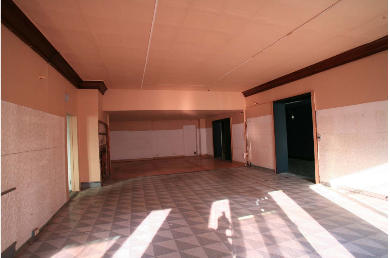
중명전 1층 서쪽방 내부(보수 전)
