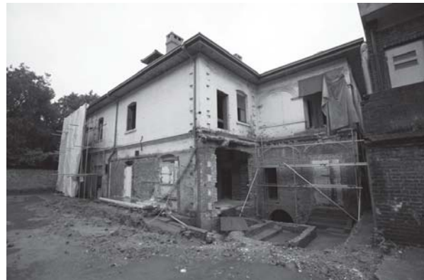
[사진 3-191] 배면 증축된 부분 철거 후 상태
