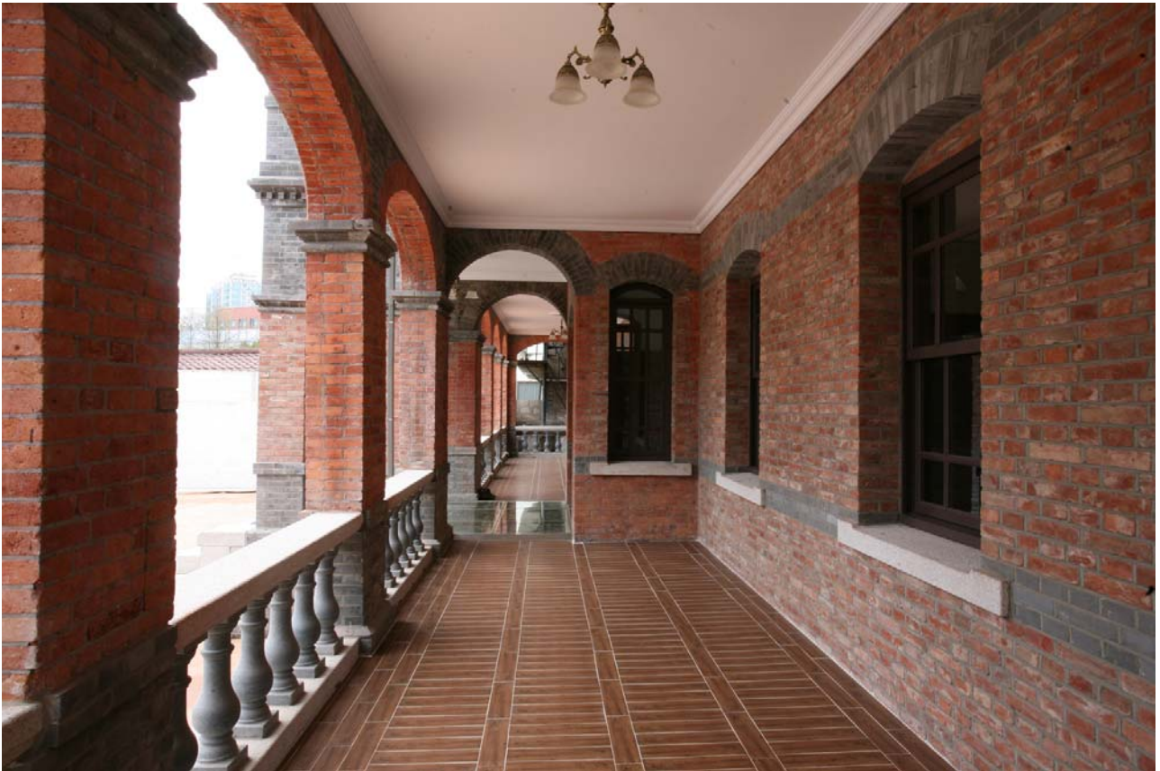
중명전 1층 남측 회랑(보수 후)
