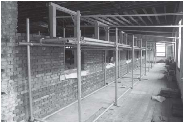
[사진 4-42] 2층 회랑 내벽 창틀 및 조적공사
