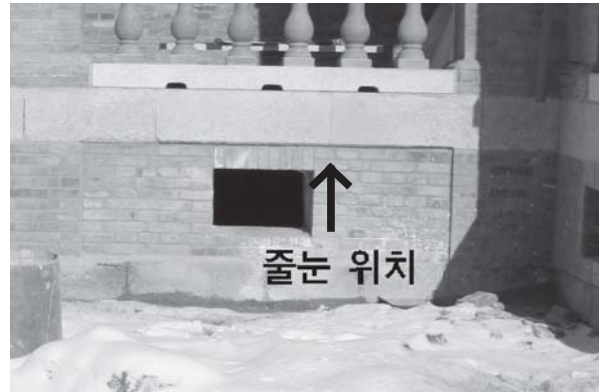
[사진 3-153] 현재 중명전의 환기구 위치와 줄눈 위치
