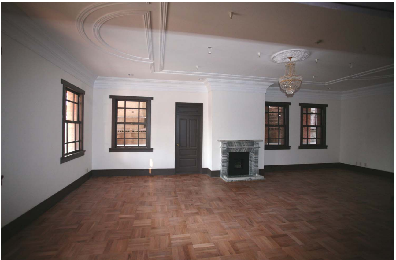
중명전 1층 서쪽방 내부(보수 후)
