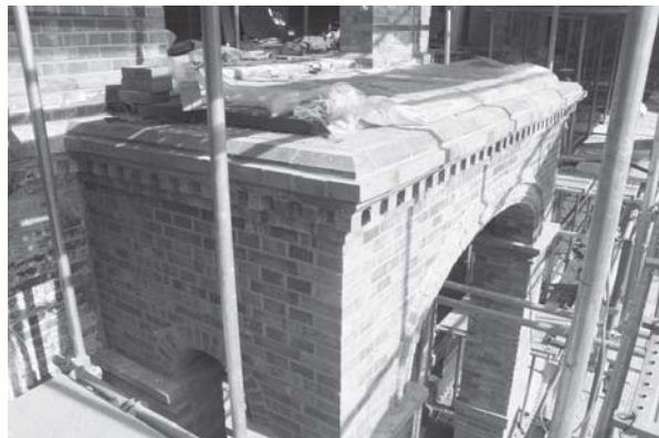
[사진 4-37] 정면 현관 상부 아치쌓기(완료 후)
