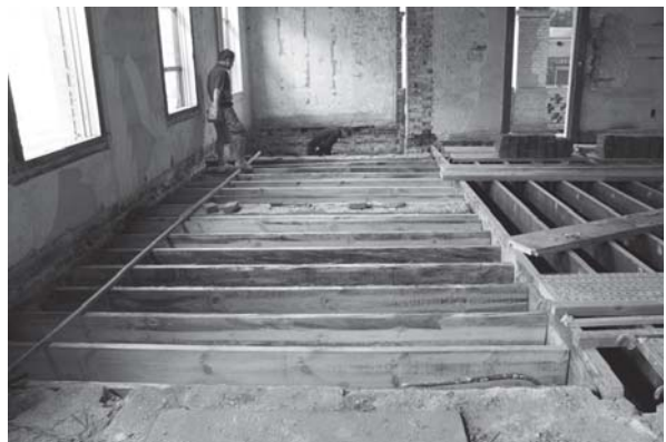
[사진 4-57] 2층 마루 장선 설치
