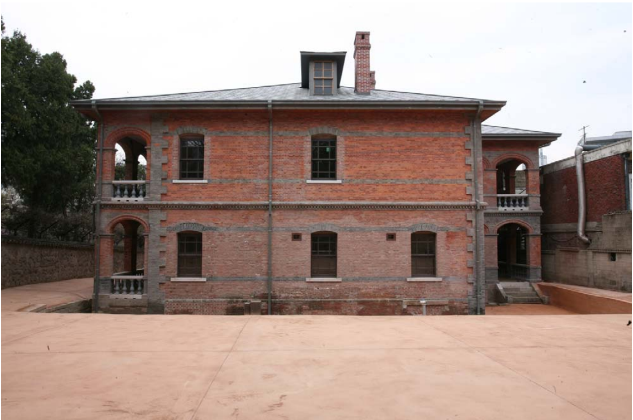
중명전 배면(보수 후)
