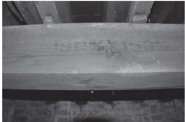
[사진 3-12] 보강보 크기 표시(180mm×150mm)
