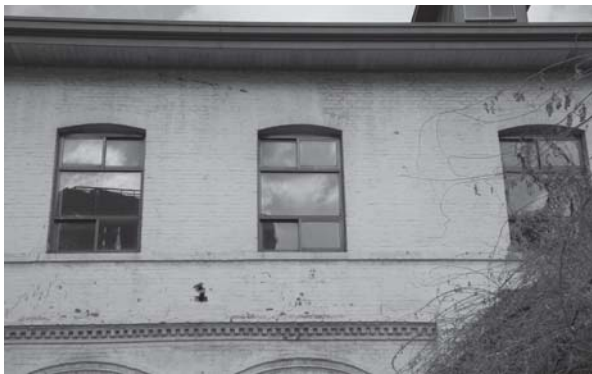
[사진 3-135] 2층 외벽에 남아 있는 아치 모양(결원형아치)
