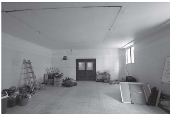
[사진 3-63] 1층 ⑦ 방향 모습
