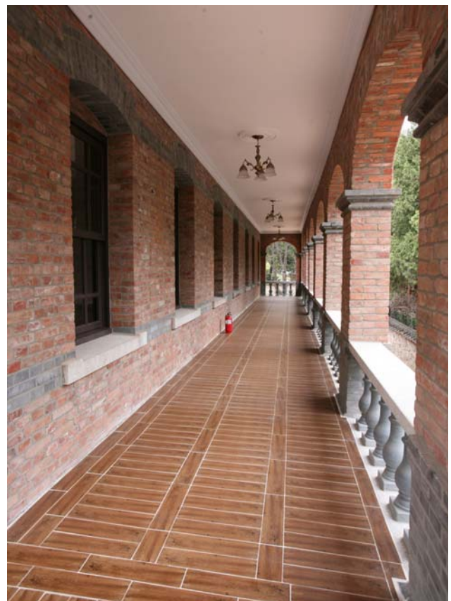
중명전 2층 서측 회랑(보수 후)
