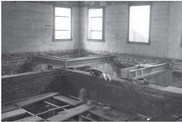
[사진 4-50] 콘크리트 보강 보 거푸집 설치
