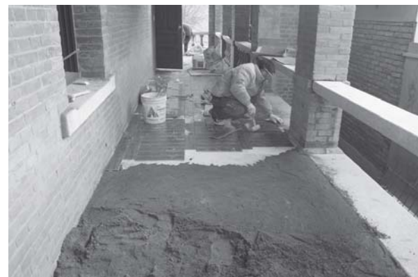
[사진 4-82] 설치몰탈위 타일 깔기
