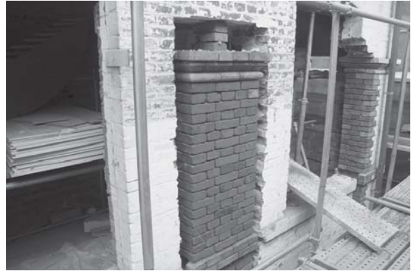
[사진 4-45] 일부 헐어낸 부분에 조적기둥 세우기
