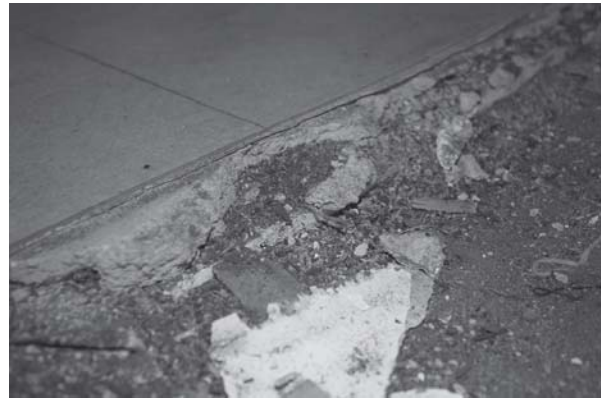
[사진 3-120] 2층 마루 바닥 마감(실 5 부분)
