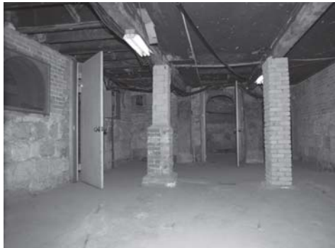
[사진 3-24] 지하 1층 ⑫ 방향 모습
