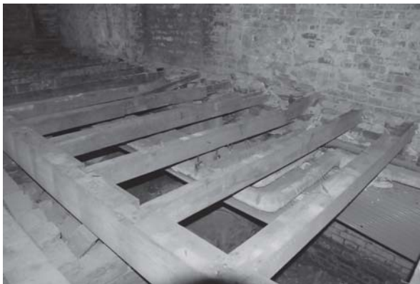
[사진 3-113] 1층 마루의 각재형 장선
