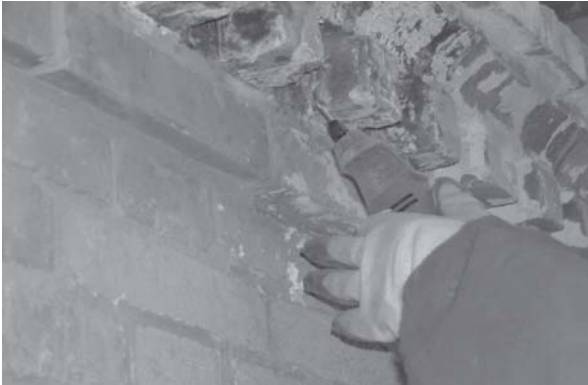
[사진 4-74] 모터툴에 의한 요철부위 및 페인트 잔재물 연마
