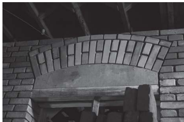
[사진 4-33] 1층 창 상부 아치틀과 벽돌쌓기(쌓기 후)
