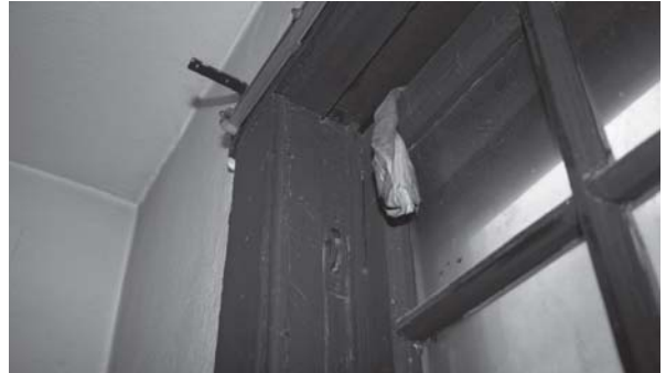
[사진 3-227] 2층 '실 2'에 있던 오르내리창 도르래
