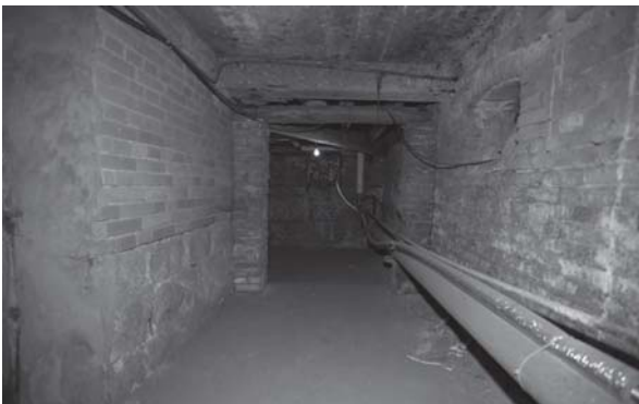
[사진 3-41] 지하 1층 ㉙ 방향 모습
