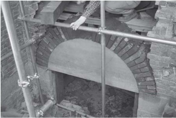
[사진 4-34] 지하 1층 아치 쌓기
