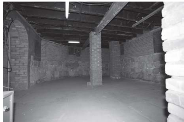
[사진 3-27] 지하 1층 ⑮ 방향 모습
