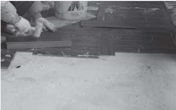
[사진 4-83] 설치몰탈 위 타일 깔기
