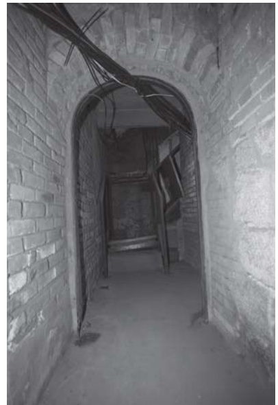
[사진 3-32] 지하 1층 ⑫ 방향 모습
