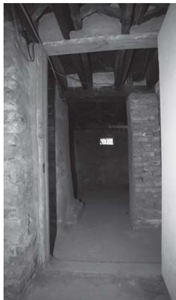
[사진 3-17] 지하 1층 ⑤ 방향 모습
