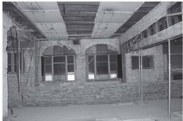
[사진 4-31] 1층 조적벽 쌓기
