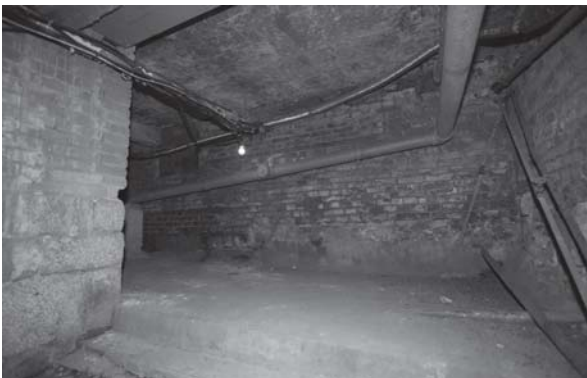
[사진 3-37] 지하 1층 ㉕ 방향 모습
