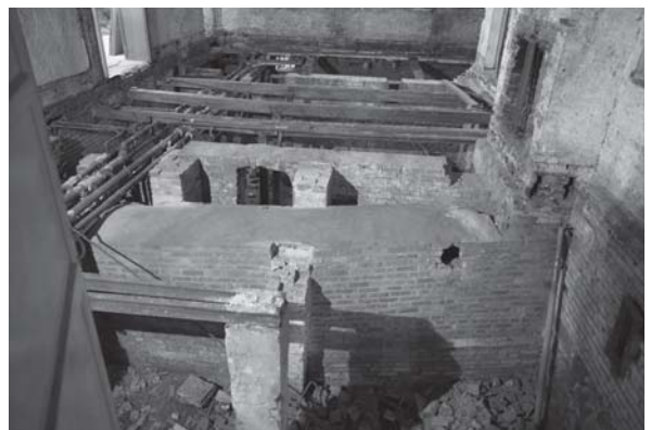
[사진 4-21] 지하 1층 '실 3', '실 2' 부분 전경
