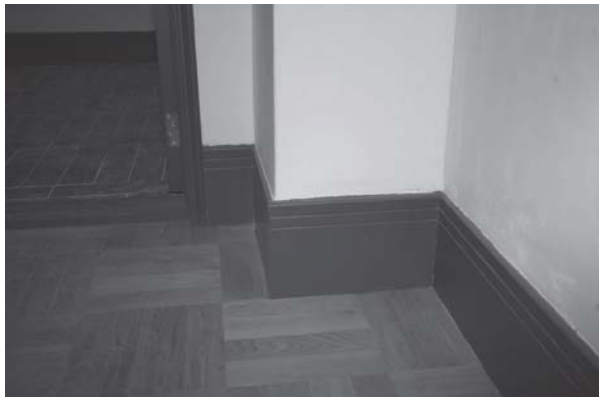
[사진 4-108] 설치된 걸레받이 몰딩
