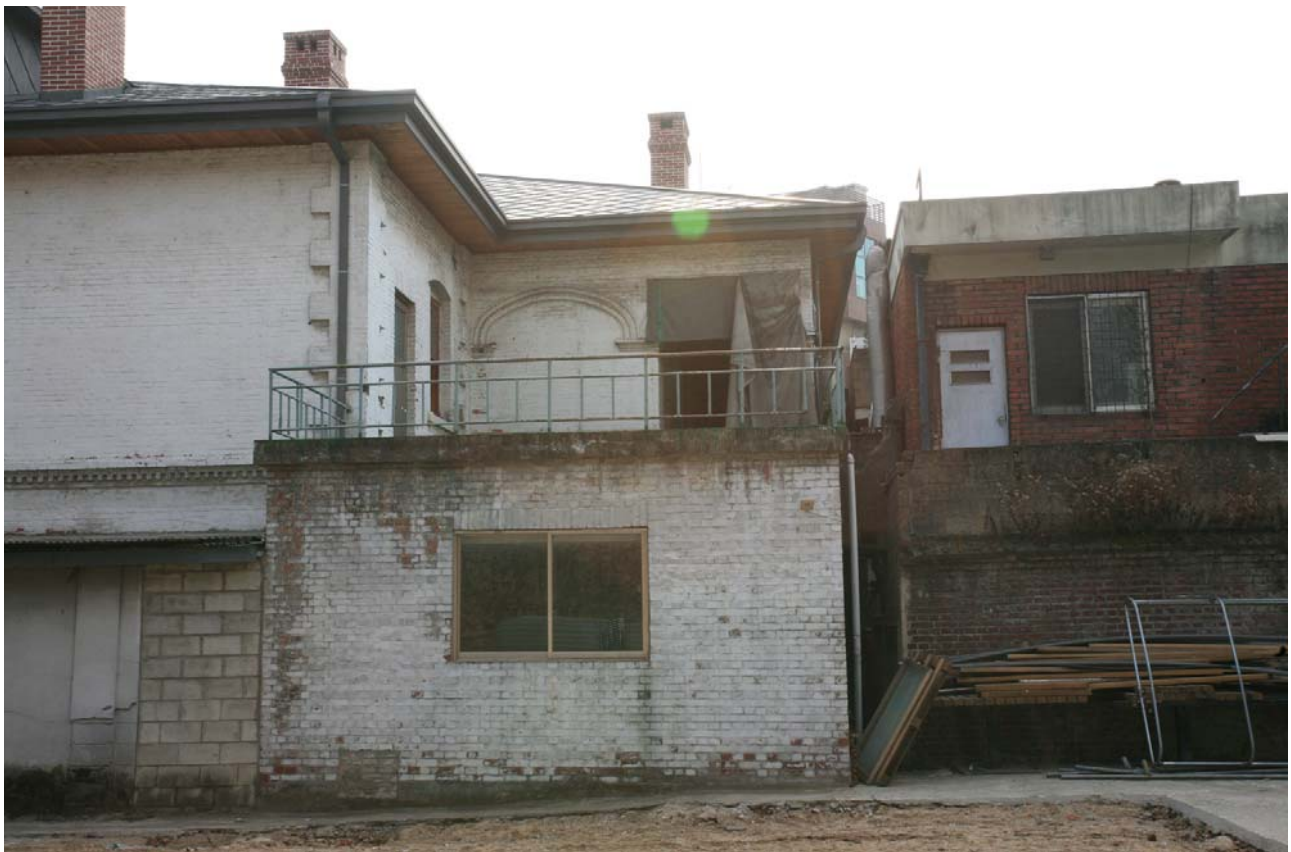
중명전 배면(보수 전)
