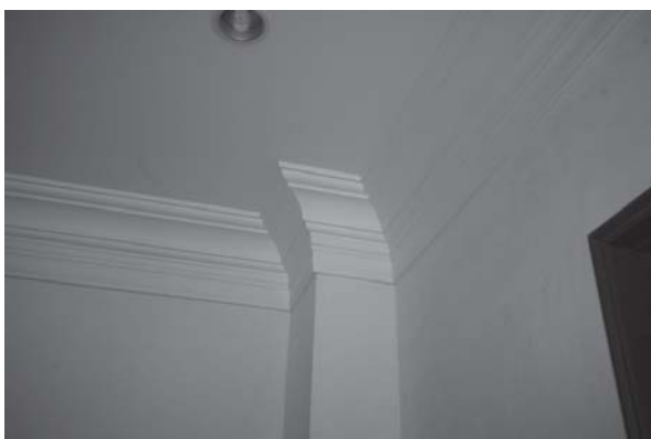
[사진 4-107] 설치된 천장 몰딩
