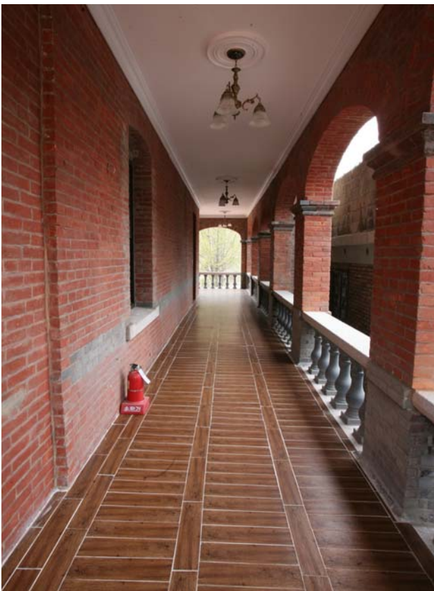
중명전 2층 서측 회랑(보수 후)
