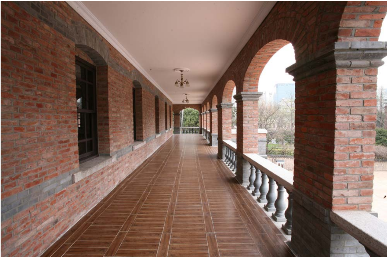
중명전 2층 남측 회랑(보수 후)
