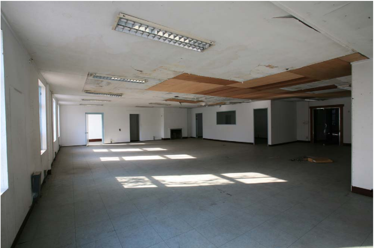
중명전 2층 남쪽방 내부(보수 전)
