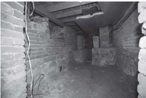
[사진 3-21] 지하 1층 ⑨ 방향 모습
