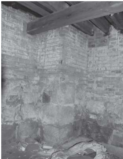
[사진 3-45] 지하 1층 ㉕ 방향 모습
