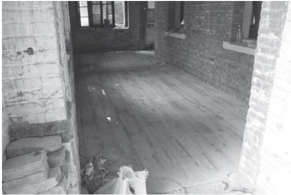
[사진 4-60] 1층 마루 설치공사
