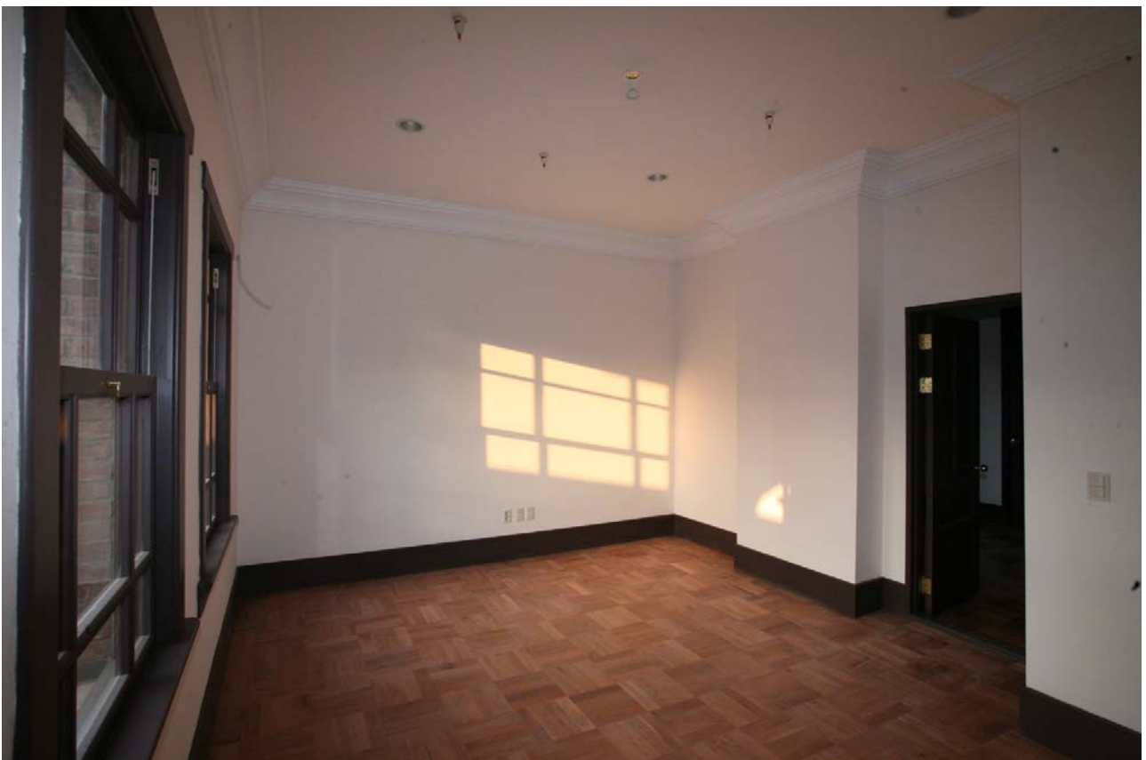
중명전 2층 북쪽 좌측방 내부(보수 후)
