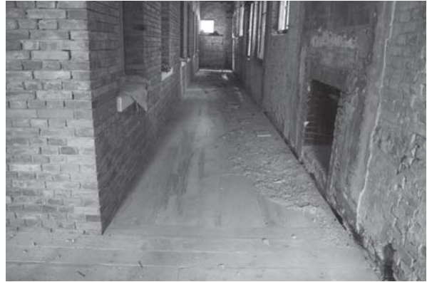
[사진 4-61] 1층 마루 설치공사
