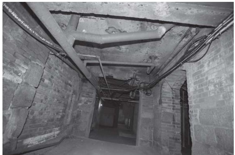
[사진 3-48] 지하 1층 ㉘ 방향 모습
