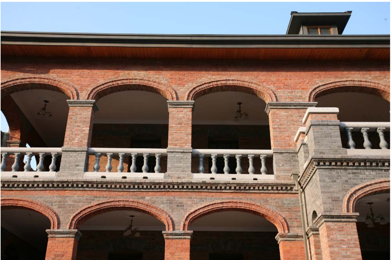
중명전 정면 2층 입면(보수 후)
