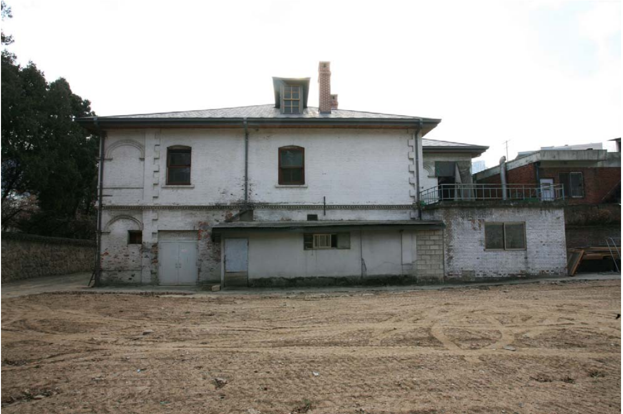
중명전 배면(보수 전)
