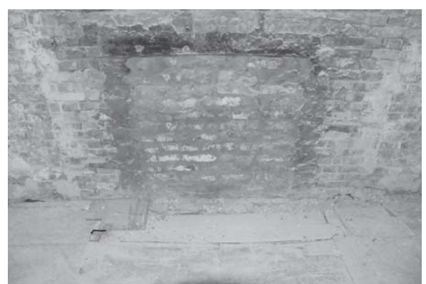
[사진 3-209] 1층 ② 벽난로 바닥
