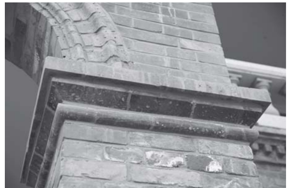
[사진 3-139] 기둥상부에 쓰인 이형벽돌(보수 후)
