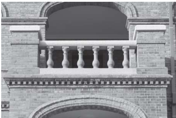
[사진 4-116] 난간 동자석 설치 완료
