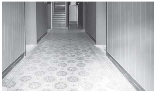
[사진 3-197] 1층 중앙통로 바닥에 깔린 타일
