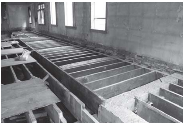
[사진 4-52] 콘크리트 보강 보 완성
