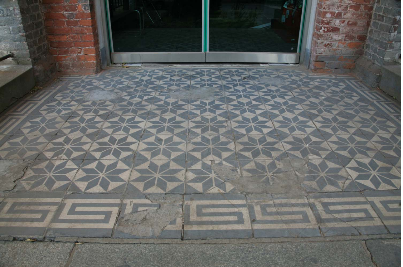
중명전 정면 입구 바닥(보수 전)
