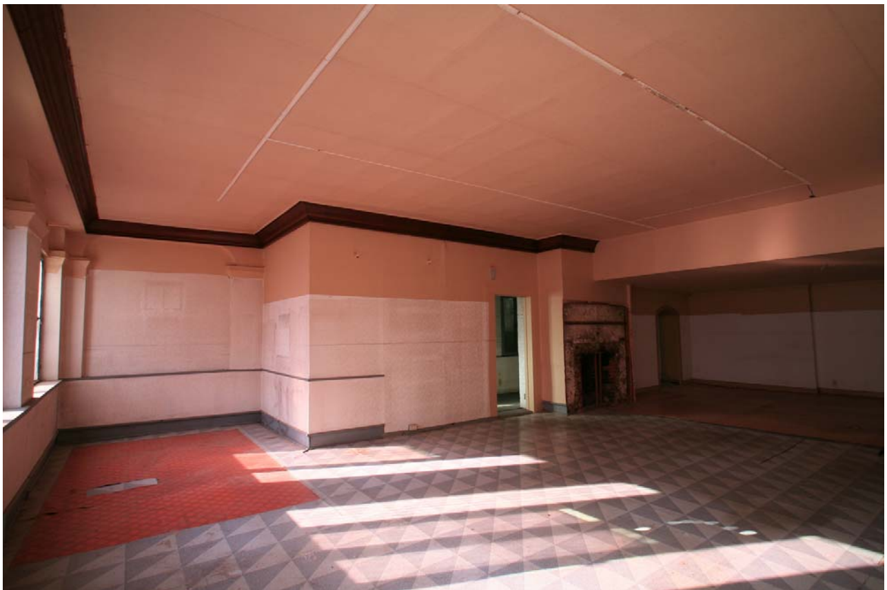
중명전 1층 서쪽방 내부(보수 전)
