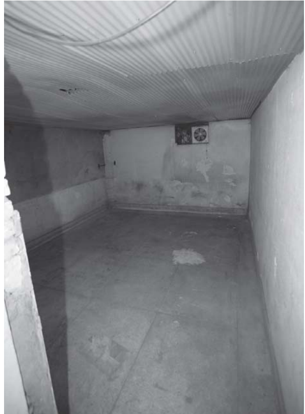
[사진 3-56] 지하 1층 ㉕ 방향 모습
