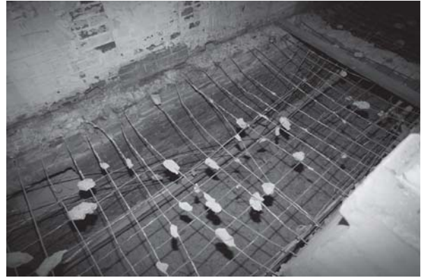
[사진 3-118] 1층 바닥 슬라브 철근
