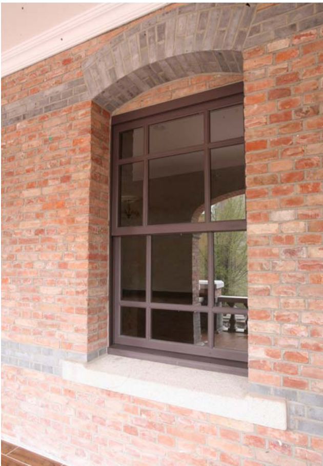
중명전 창문(보수 후)
