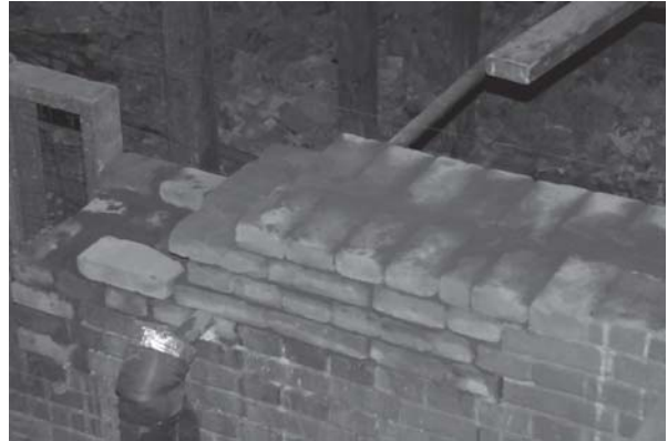
[사진 3-5] 중명전의 2매쌓기 벽체구성의 시공현황사진(마구 리면이 보이는 커)
