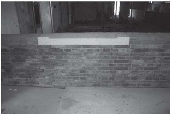
[사진 4-30] 1층 조적벽 위 창대석 설치
