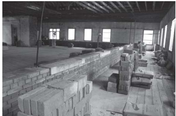
[사진 4-41] 2층 회랑 내벽 창대석 설치
