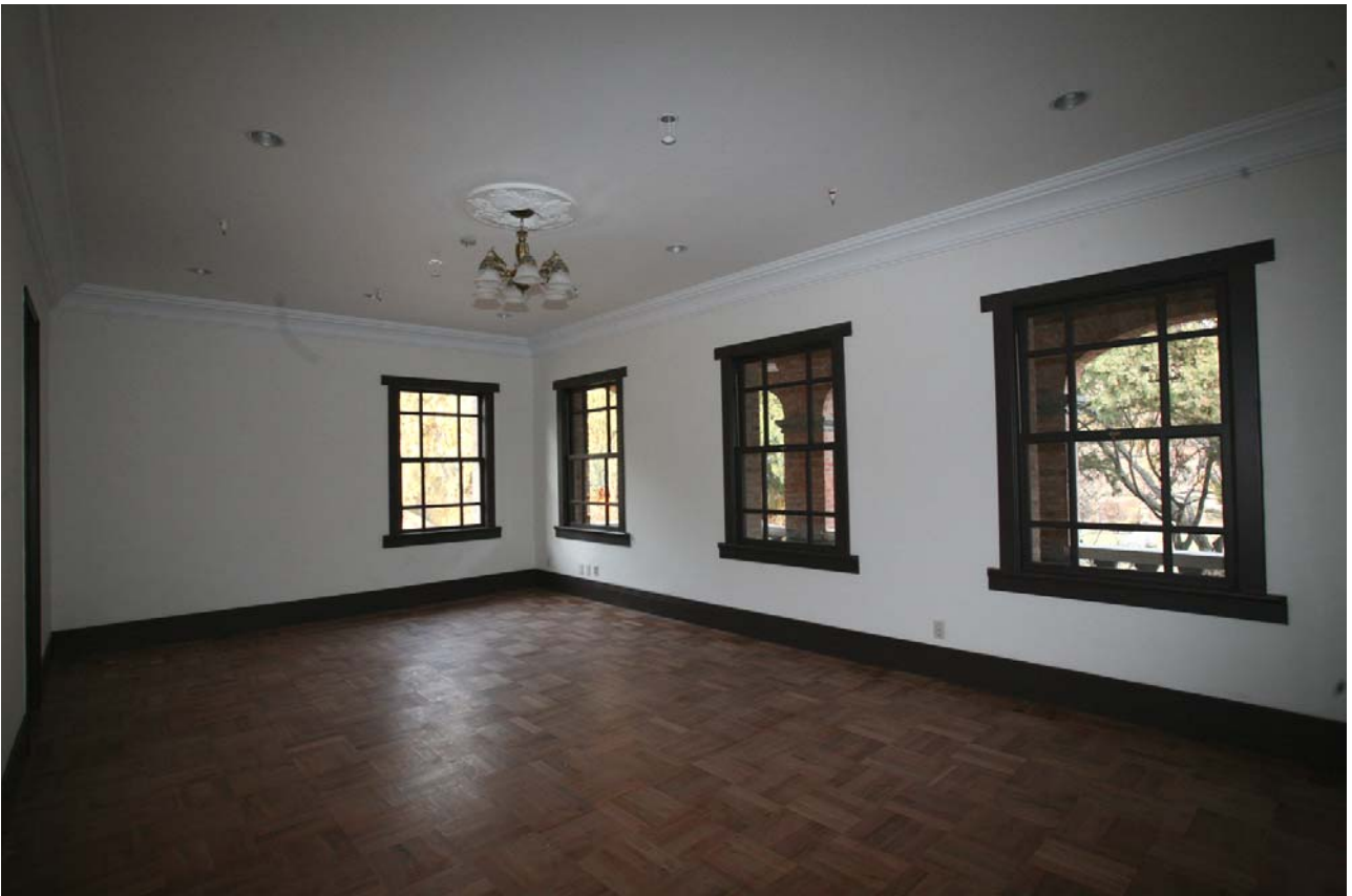
중명전 2층 북쪽 우측방 내부(보수 후)
