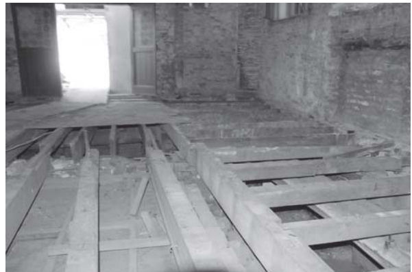
[사진 3-114] 1층 마루의 각재형 장선
