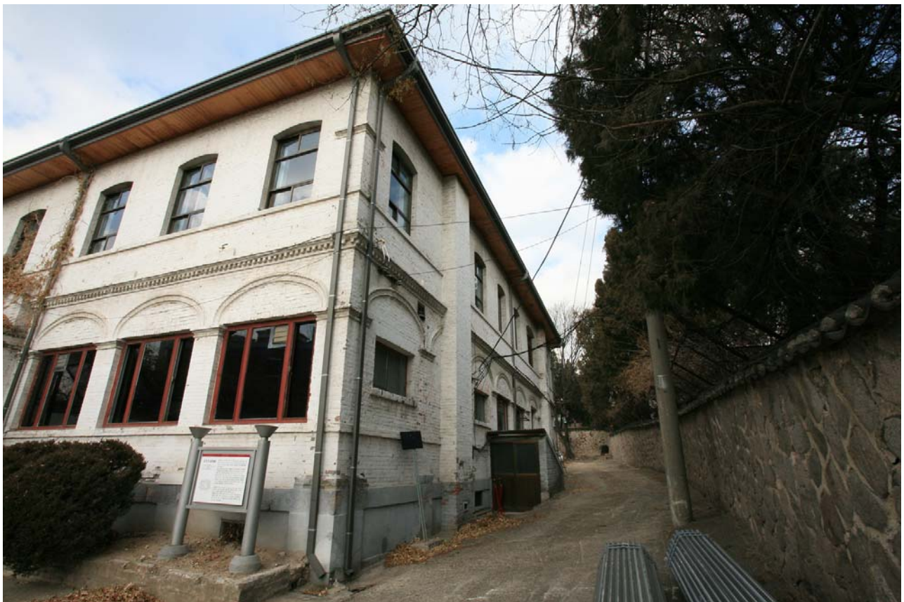
중명전 우측면(보수 전)
