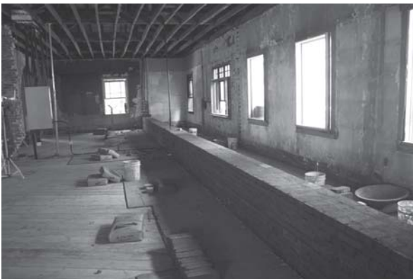
[사진 4-40] 2층 회랑 내벽 조적공사
