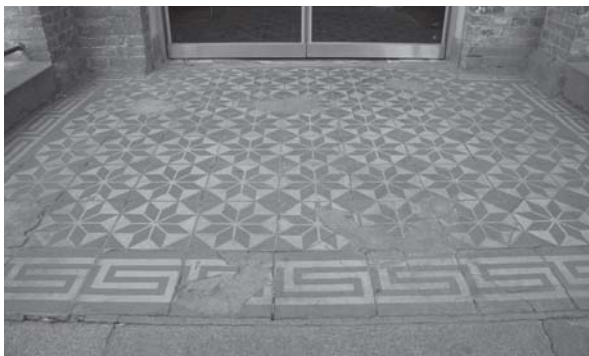
[사진 3-196] 1층 정면 출입구 바닥에 깔린 타일
