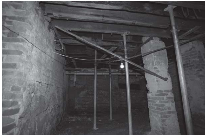
[사진 3-46] 지하 1층 ㉖ 방향 모습
