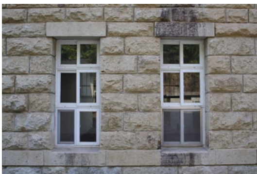
사진 3-21. 정면 1층 상세. (상인방과 하부 돌림띠는 잔다듬으로 되어있다)
