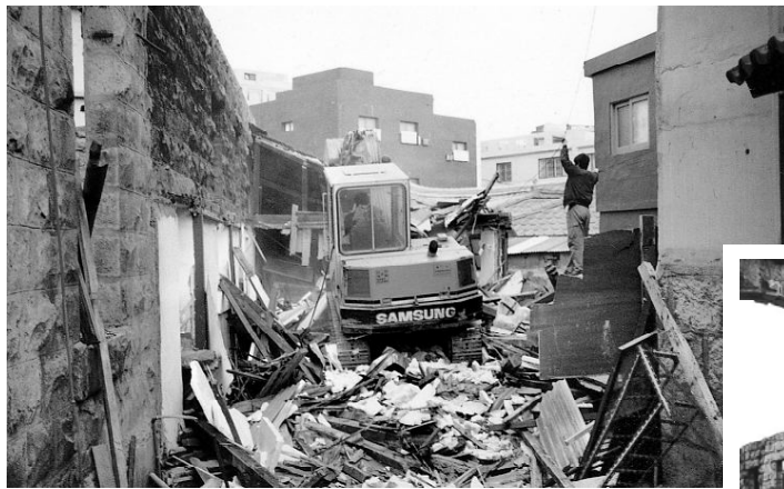
〈사진 12〉 대수선을 위한 지붕 및 부속사 철거 모습(1994년 초)
